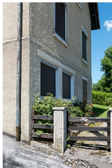
Baies d'atelier à l'étage de soubassement. Phot. Sonia Dourlot
