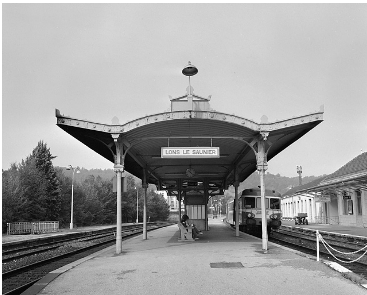
Abri métallique sur le quai.
