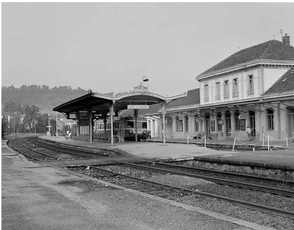
Façade postérieure et abri sur le quai.
