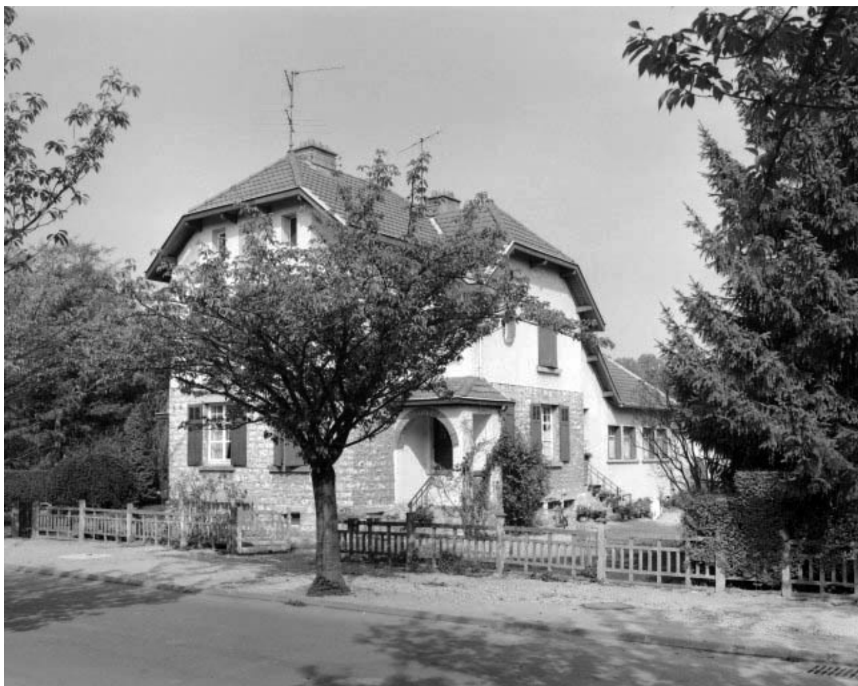
Façade antérieure et face droite.
