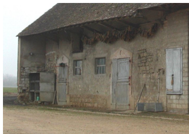
Vue d'ensemble de la façade.
