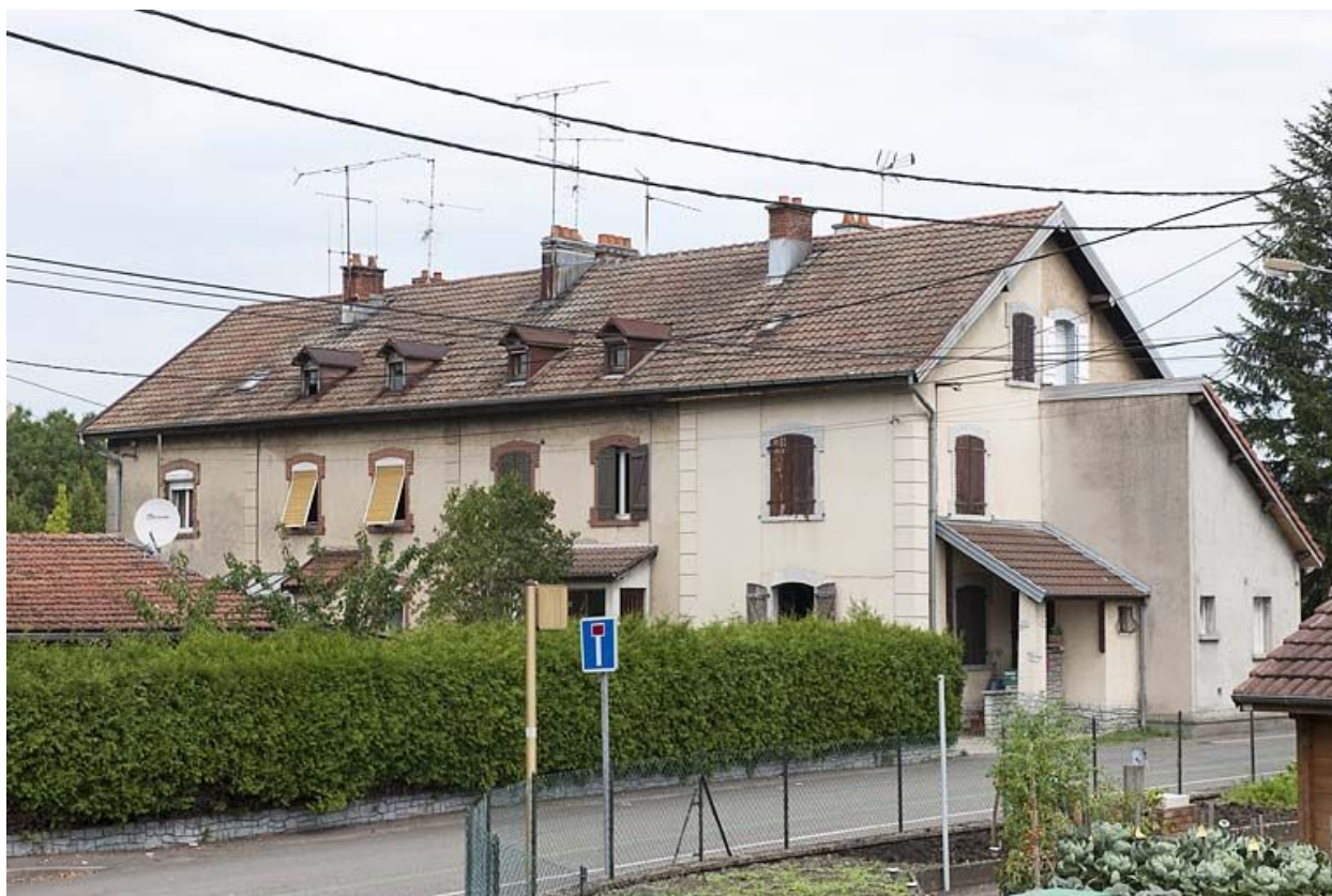
Habitation à 8 logements. Vue depuis le sud.
