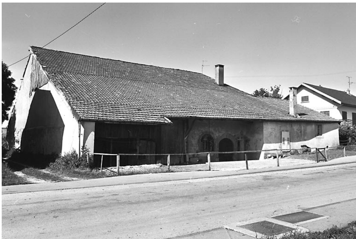
Ferme située rue des Auges : vue d'ensemble.
