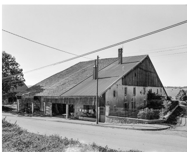
Ferme située rue Sur la Côte : vue d'ensemble. Phot. Bernard Lardière IVR43_19782500307X
