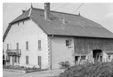
Ferme haute datée de 1814 : vue d'ensemble. Phot. Gilbert Poinot IVR43_19752501415Z
