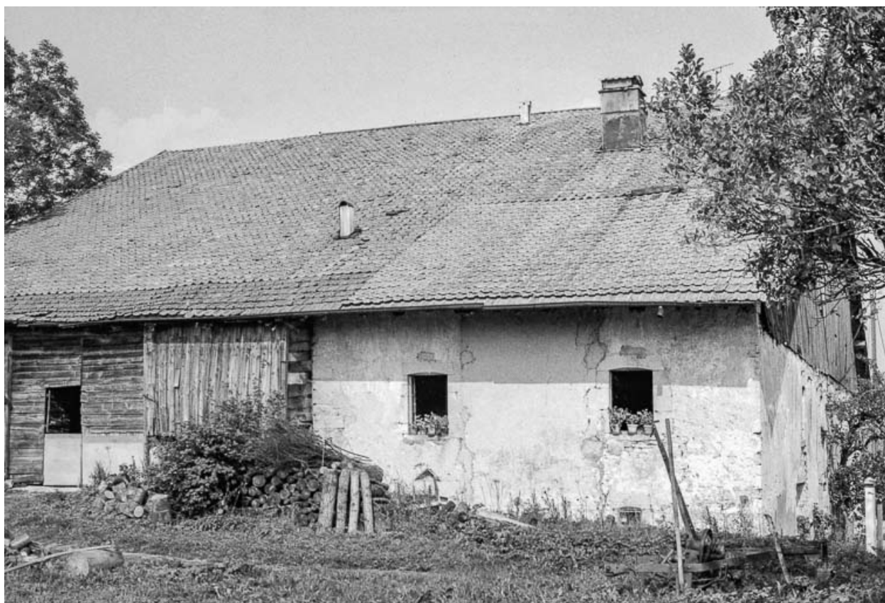
Ferme : façade postérieure.
