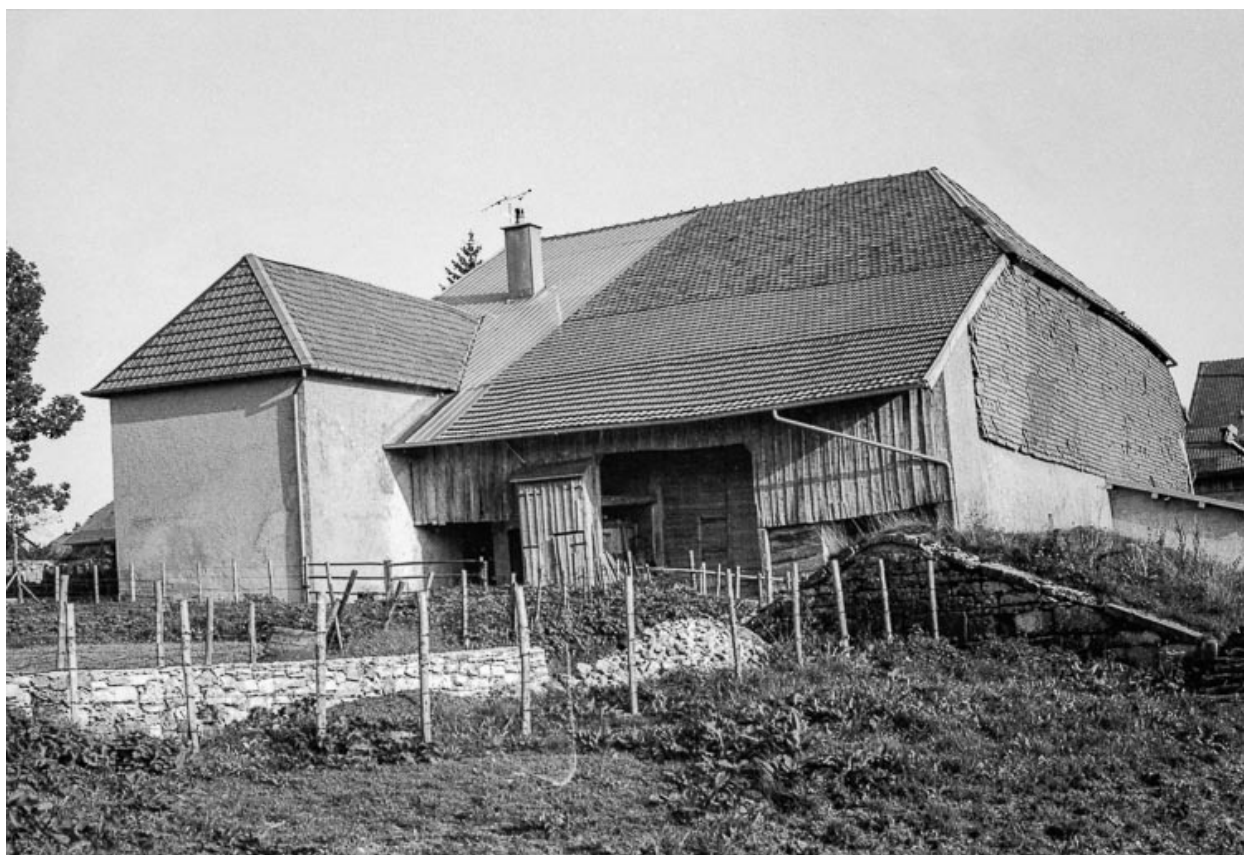
Ferme : façade postérieure.
