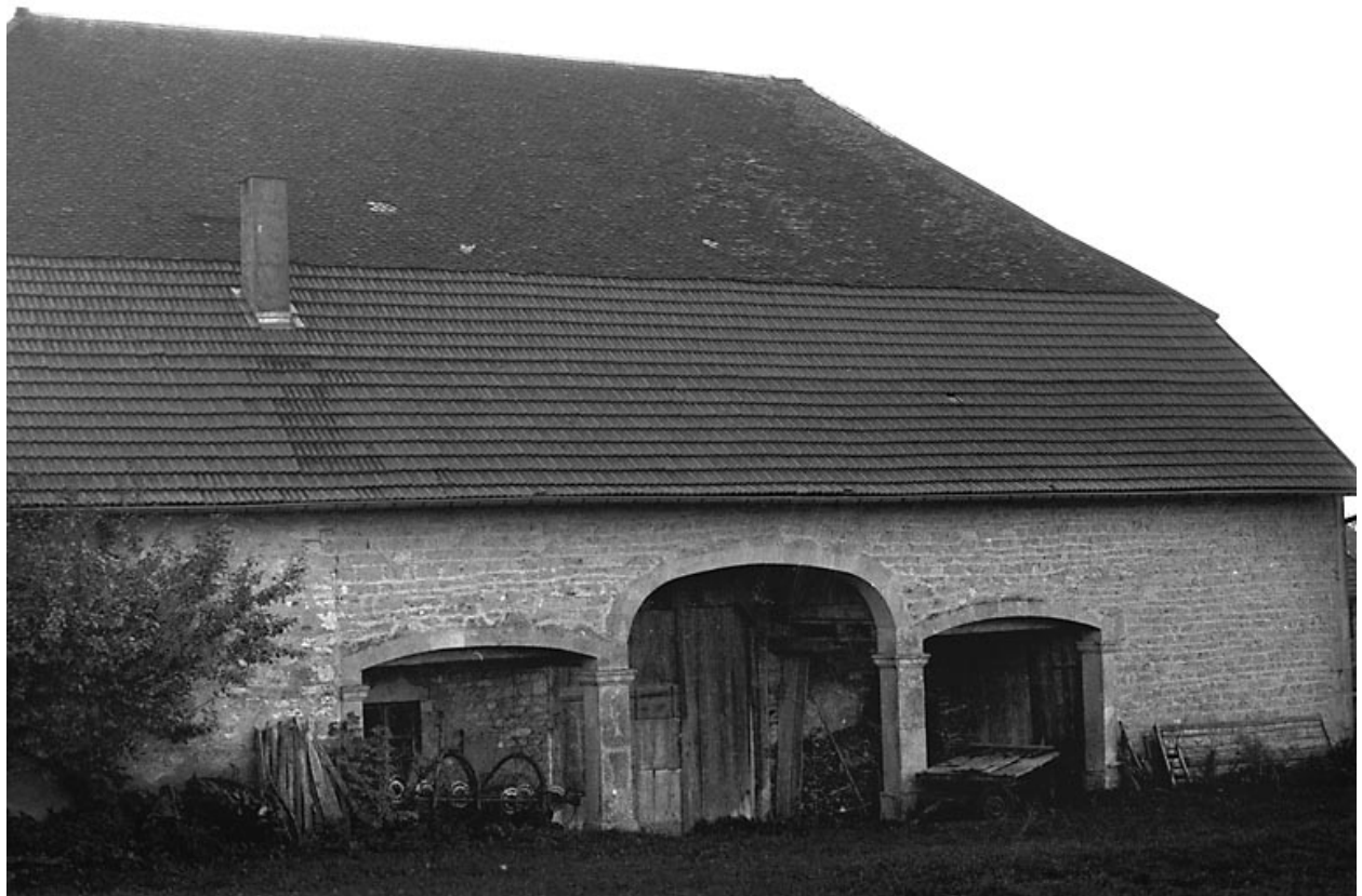
Ferme située rue Bergeon : façade postérieure.
