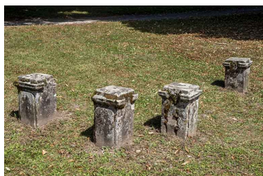
Dés de garde-corps. Phot. Jérôme Mongreville IVR43_20207000396NUC4A
