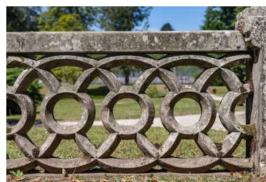
Garde-corps, détail. Phot. Jérôme Mongreville IVR43_20207000387NUC4A
