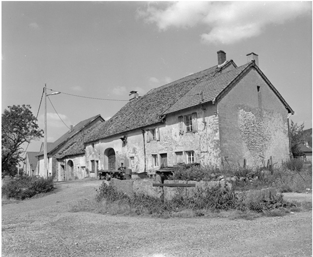
Façades antérieures de fermes.
