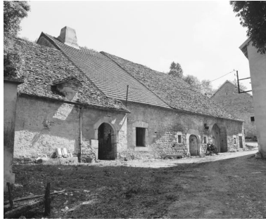
Façade antérieure de ferme.
