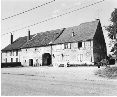
Façades antérieures de fermes.
