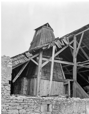
Ferme à "tué" : hotte du "tué" et charpente. Phot. Bernard Lardière IVR43_19782500232X
