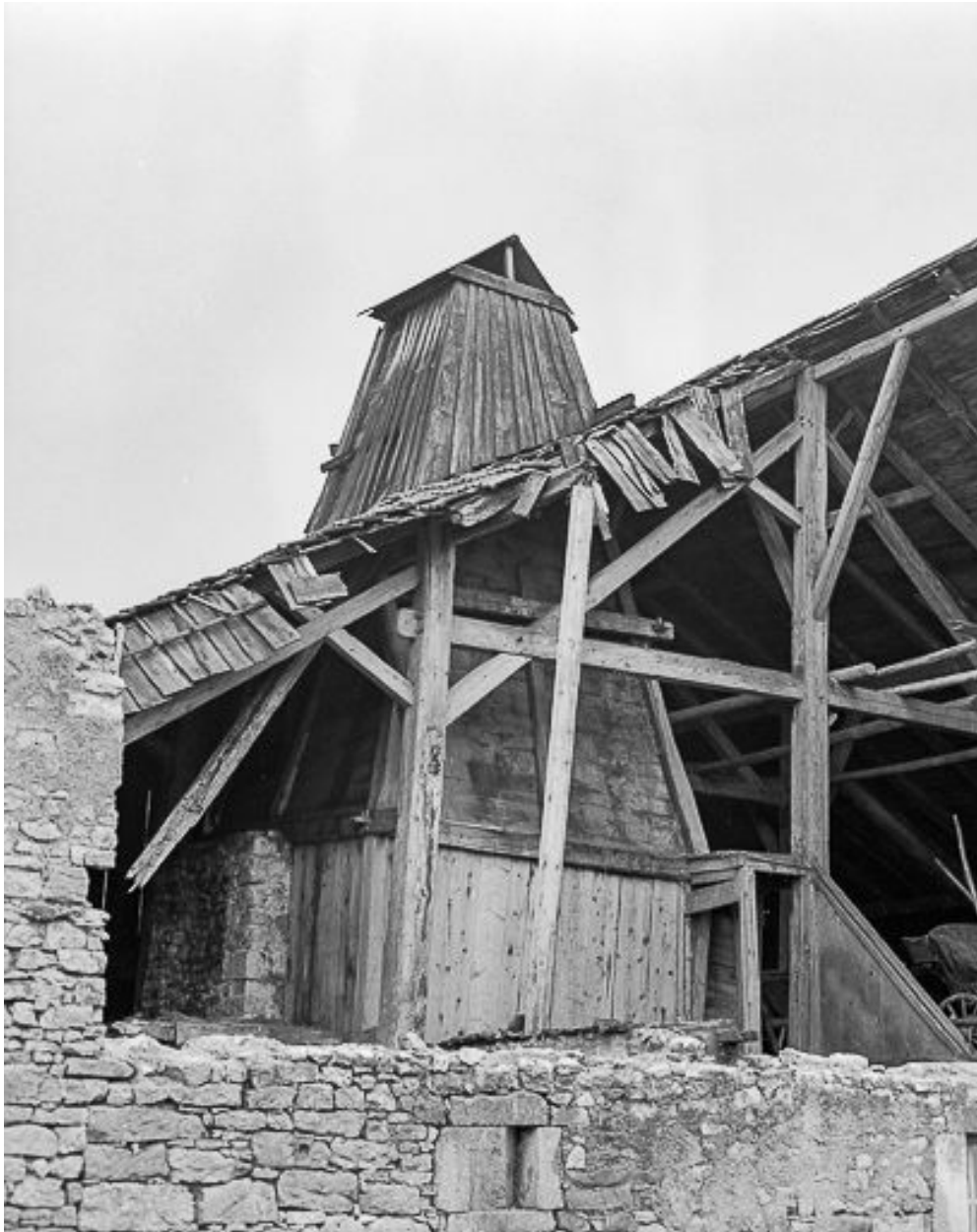
Ferme à "tué" : hotte du "tué" et charpente.
