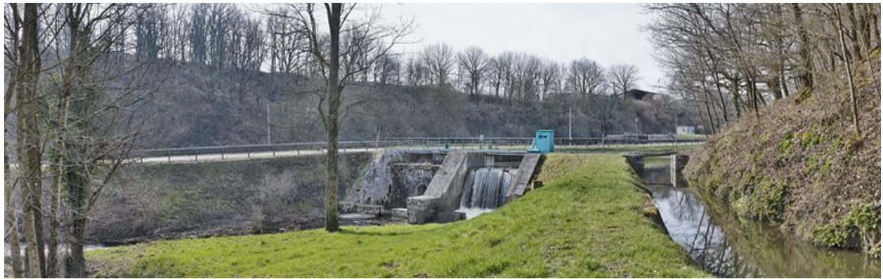
Vue d'ensemble du barrage. A droite, on distingue la rigole d'alimentation.
