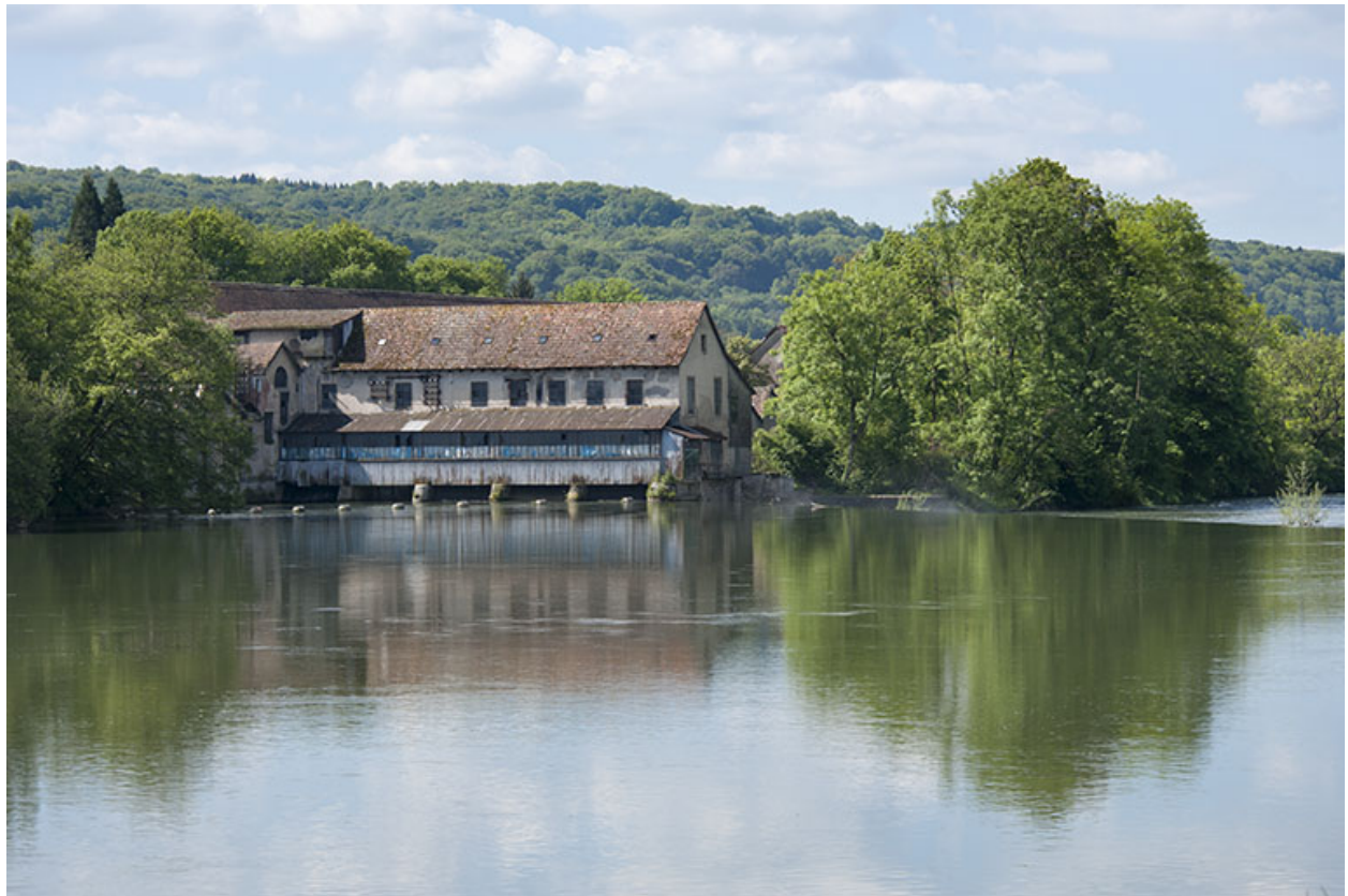
Bâtiment d'eau depuis l'amont.
