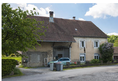
Logement ouvrier. Phot. Jérôme Mongreville IVR43_20132500447NUC4A
