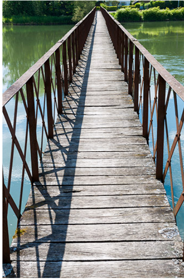
La passerelle. Vue rapprochée. Phot. Jérôme Mongreville IVR43_20132500454NUC4A
