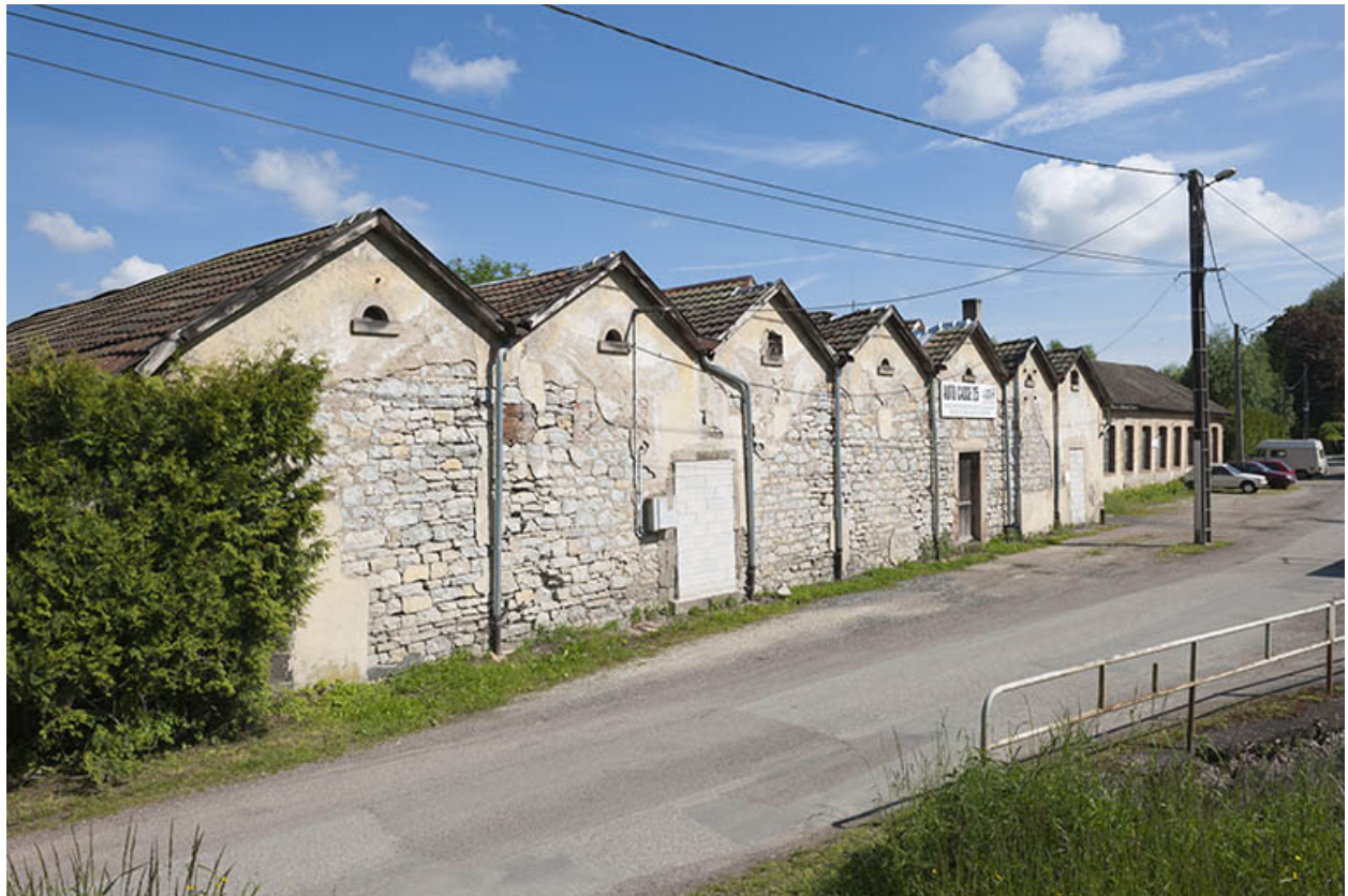
Murs-pignons de l'atelier de filature.
