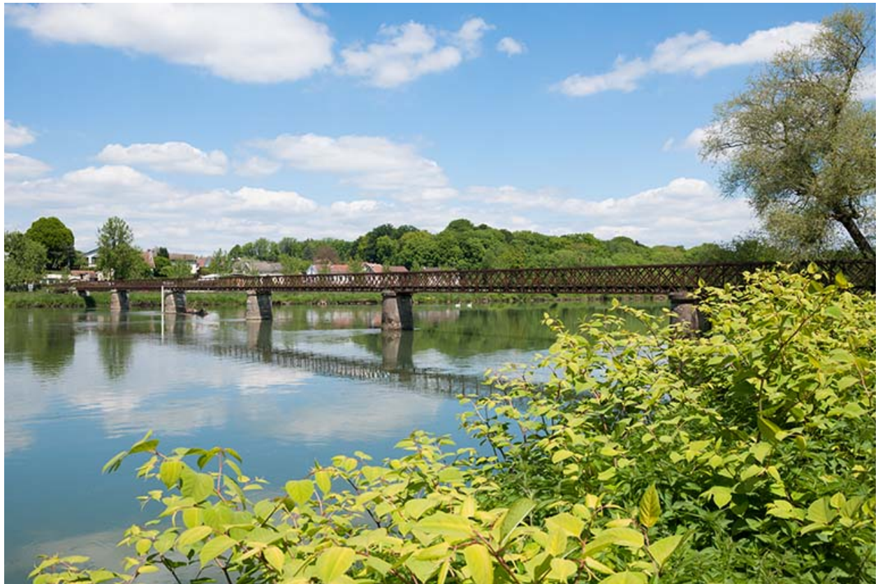
La passerelle vue depuis la rive gauche.
