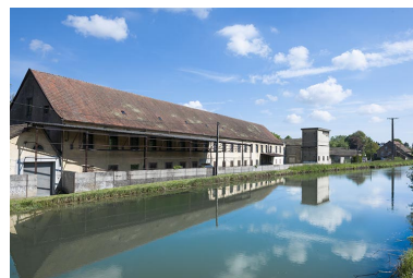
Atelier de tissage longeant le canal. Phot. Jérôme Mongreville IVR43_20132500440NUC4A
