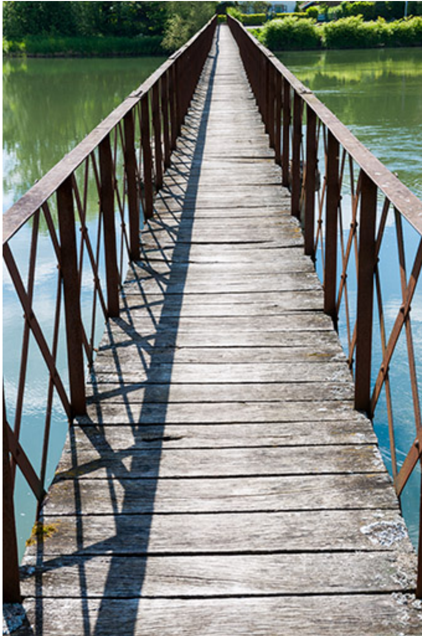
La passerelle. Vue rapprochée.
