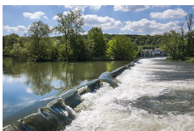
Le barrage depuis la rive droite. Phot. Jérôme Mongreville IVR43_20132500446NUC4A
