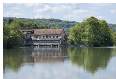
Bâtiment d'eau depuis l'amont. Phot. Jérôme Mongreville IVR43_20132500445NUC4A
