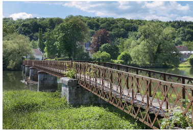
La passerelle depuis la rive droite. Phot. Jérôme Mongreville IVR43_20132500452NUC4A
