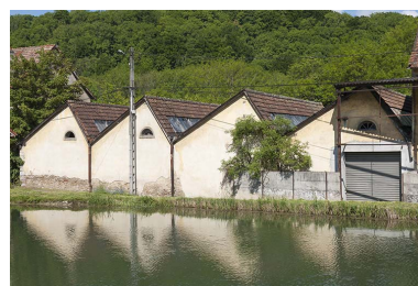
Magasin ou entrepôt industriel. Phot. Jérôme Mongreville IVR43_20132500441NUC4A
