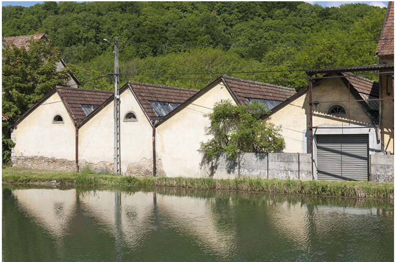
Magasin ou entrepôt industriel.
