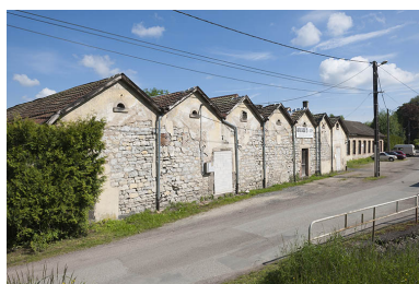
Murs-pignons de l'atelier de filature. Phot. Jérôme Mongreville IVR43_20132500437NUC4A
