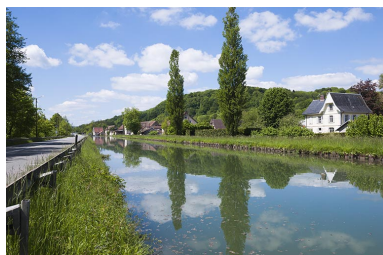
Vue d'ensemble depuis le canal, au nord-est. Phot. Jérôme Mongreville IVR43_20132500448NUC4A
