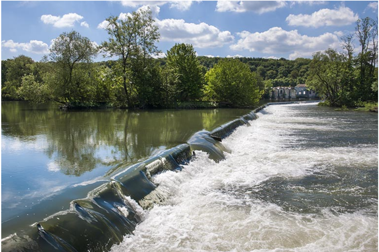
Le barrage depuis la rive droite.
