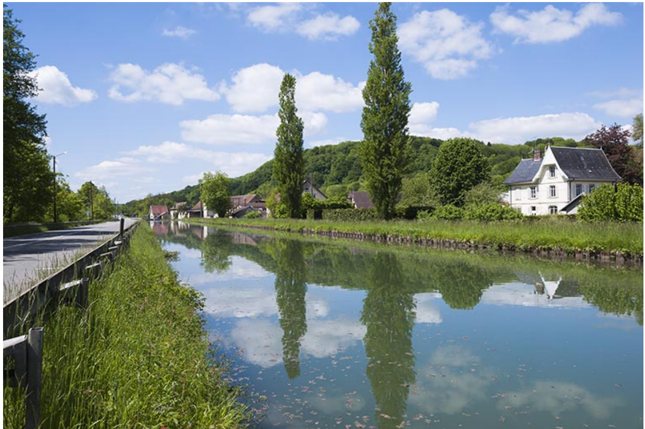
Vue d'ensemble depuis le canal, au nord-est.
