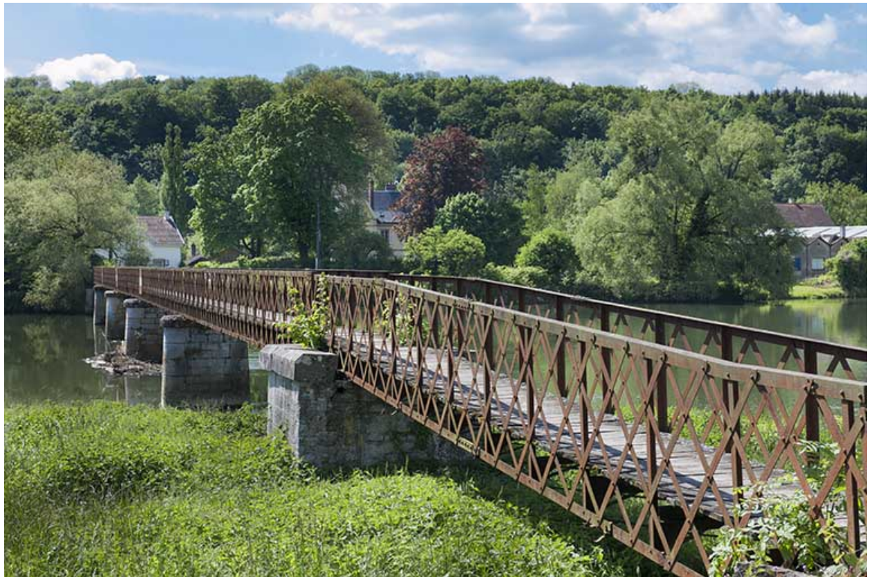
La passerelle depuis la rive droite.
