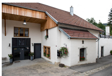
Forge et abri du moteur. Phot. Sonia Dourlot IVR43_20172501237NUC4A
