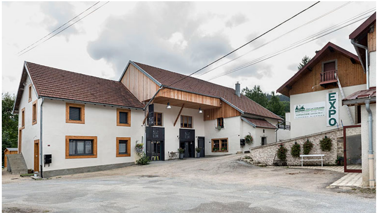
Tournerie de manches (à gauche) et forge (à droite).
