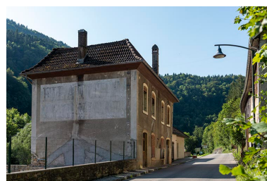
Logement, de trois quarts gauche (élevations antérieure et latérale gauche). Phot. Sonia Dourlot IVR43_20192501455NUC4A
