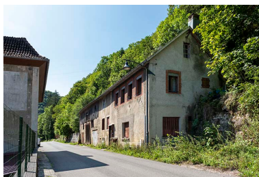
Logement occidental : vue d'ensemble, depuis le nord.
