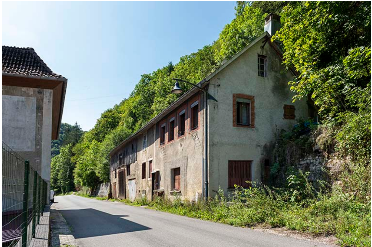
Logement occidental : vue d'ensemble, depuis le nord.
