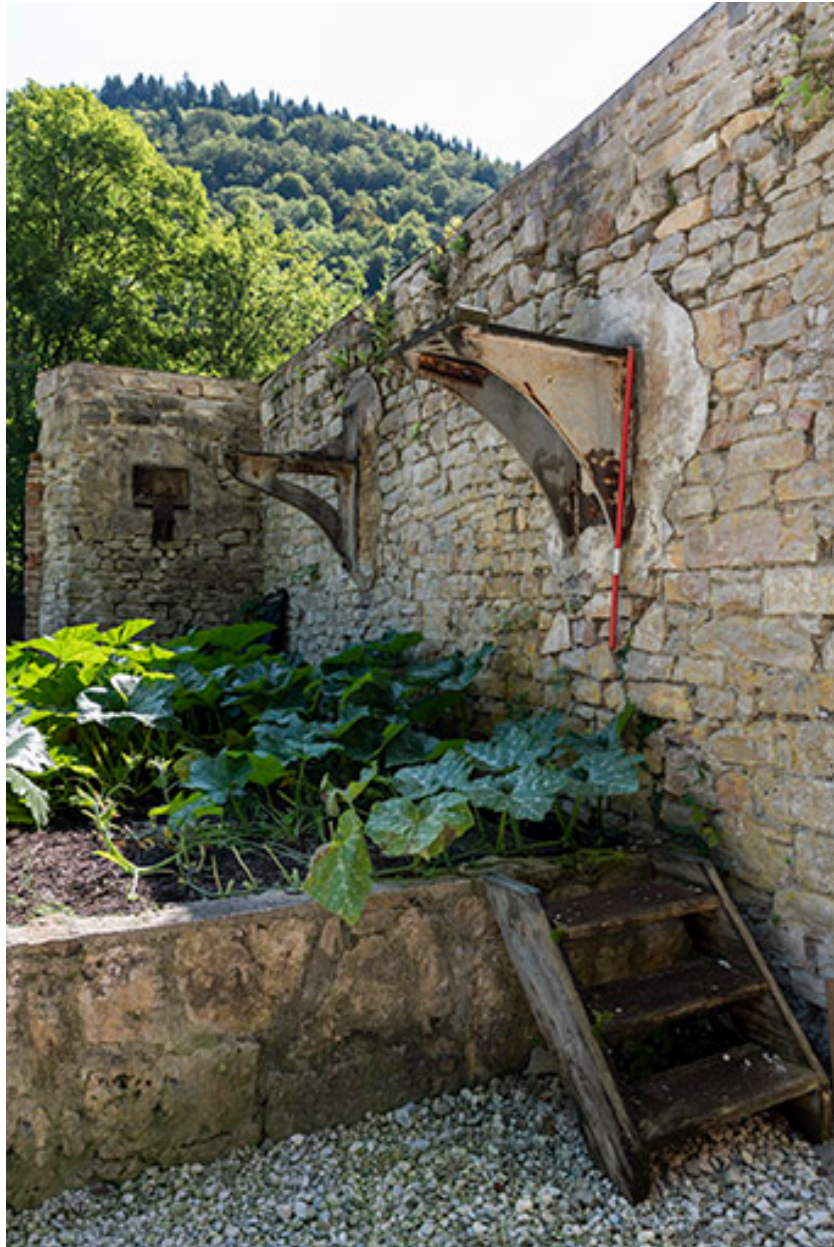
Vestiges de l'usine : supports de transmission.
