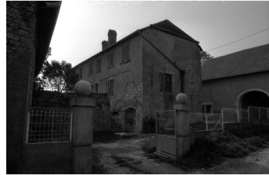
Maison d'habitation : façades antérieure et latérale droite. Phot. Bernard Lardière IVR43_19797000085Z
