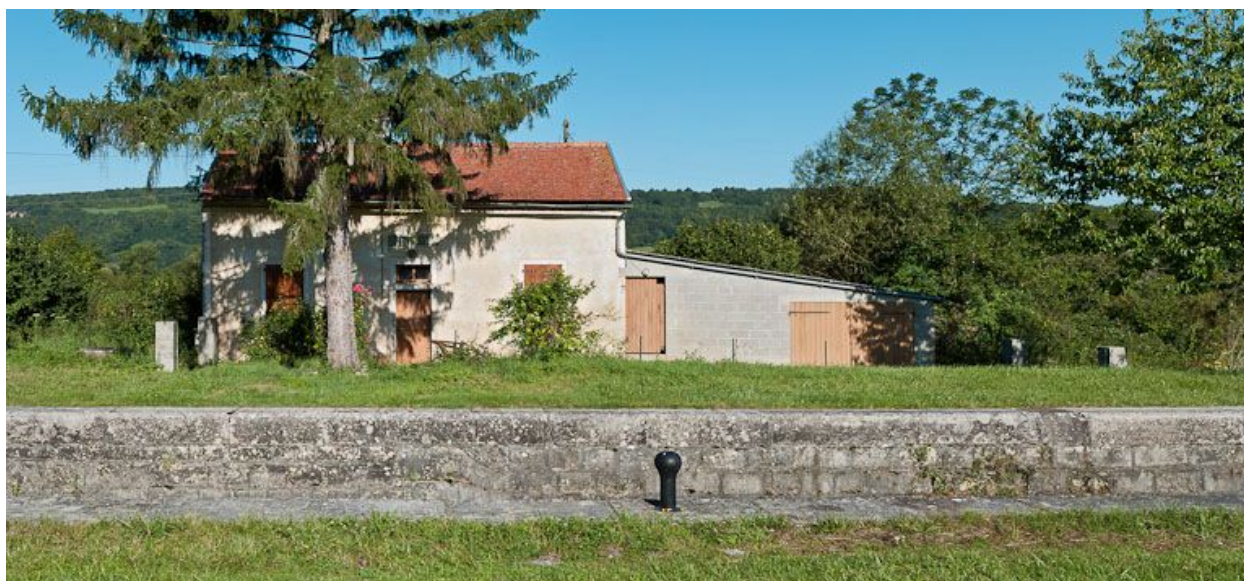
Vue de face de la maison éclusière.
