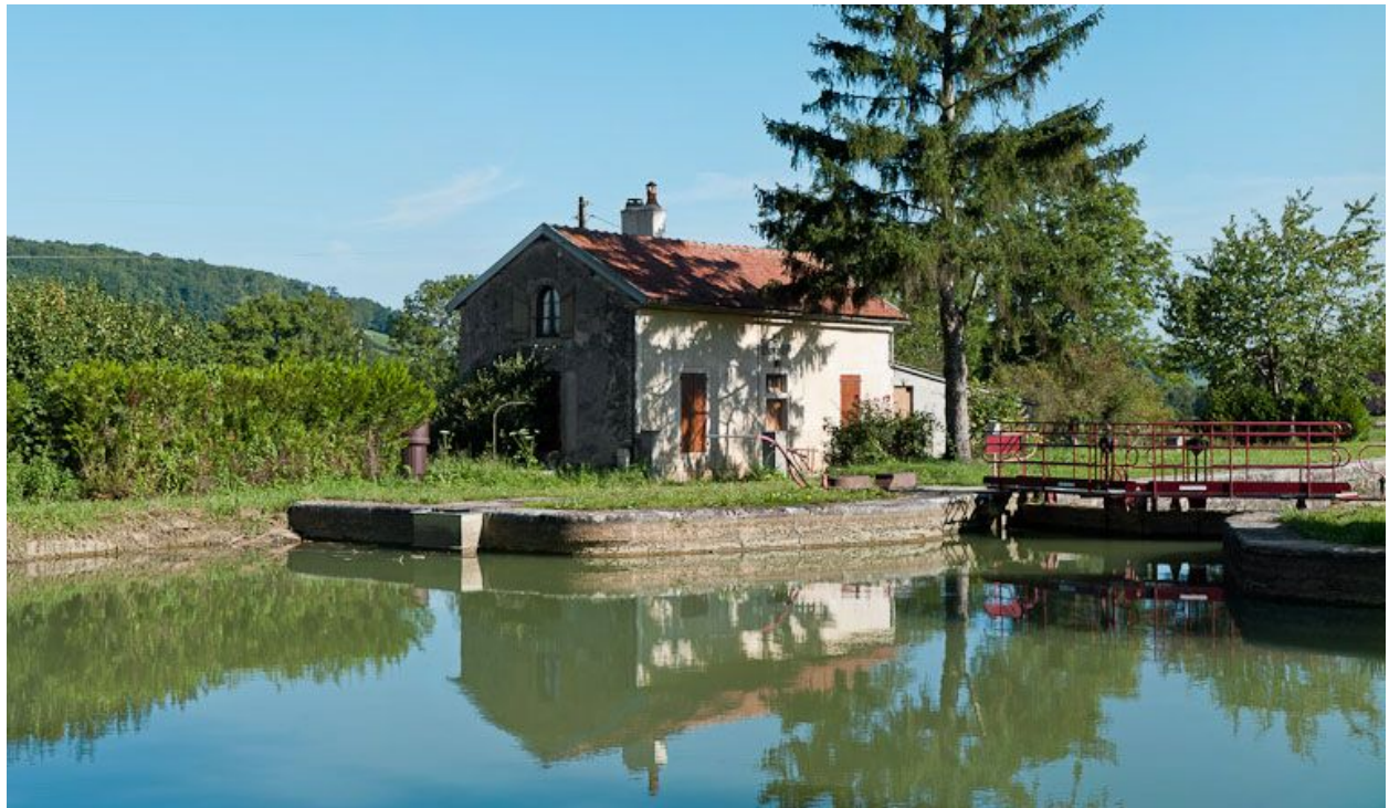
Vue du site d'écluse depuis l'amont.
