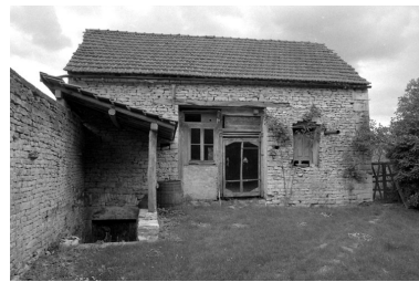
Remise sur cave. Phot. Bernard Lardière IVR43_19817000557Z
