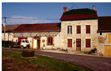
Vue d'ensemble. Phot. Jérôme Mongreville IVR43_19953900135ZA
