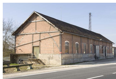
Magasin industriel depuis le nord-est. Phot. Jérôme Mongreville IVR43_20097000126NUC2A
