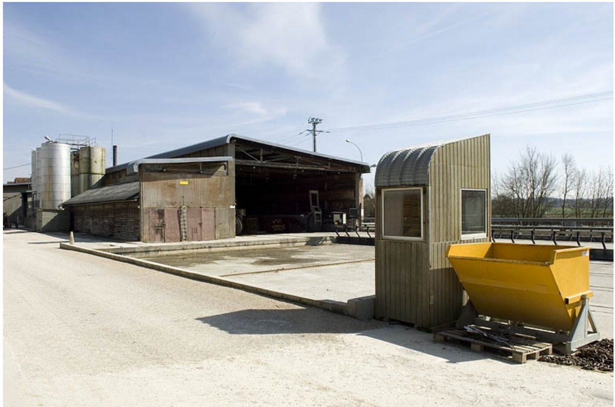
Atelier de fabrication depuis le nord-ouest.
