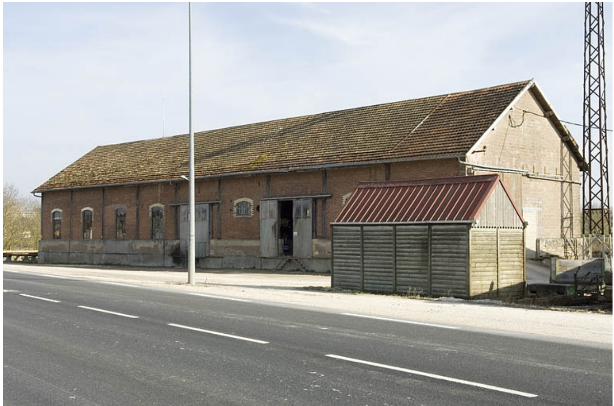
Magasin industriel depuis le nord-ouest.
