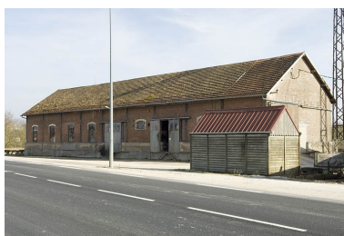
Magasin industriel depuis le nord-ouest. Phot. Jérôme Mongreville IVR43_20097000123NUC2A
