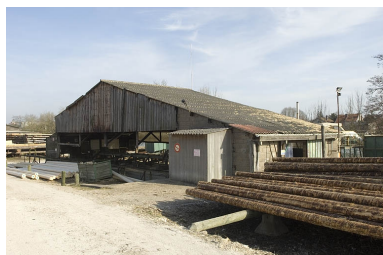
Atelier d'écorçage et de perçage. Phot. Jérôme Mongreville IVR43_20097000124NUC2A
