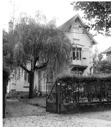
Maison de contremaître rue d'Alsace. Phot. Yves Sancey IVR43_20029000450X
