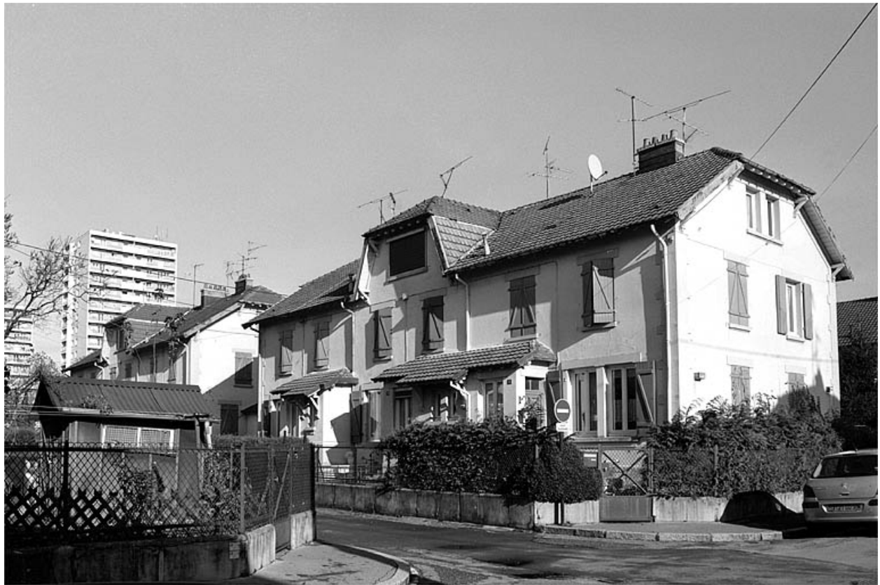
Vue de trois quarts d'un logement ouvrier.
