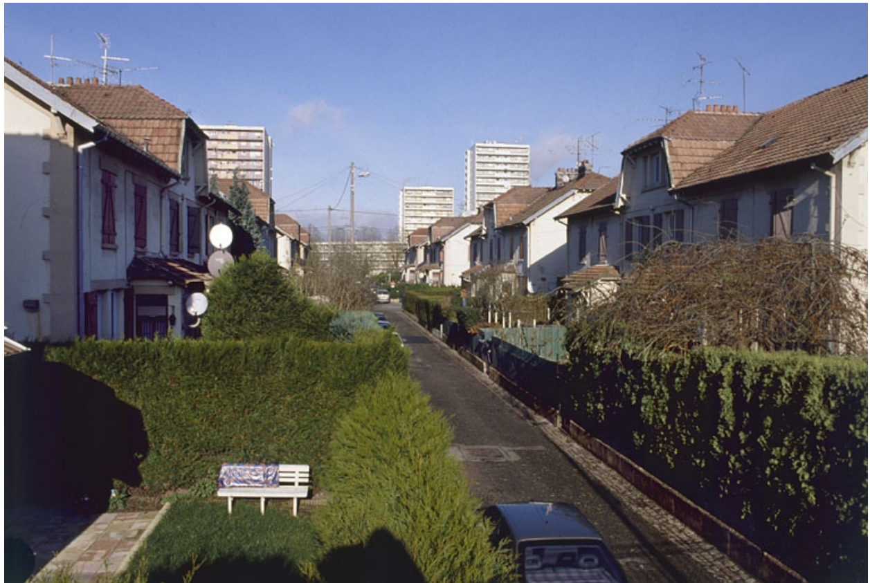
Vue d'ensemble d'une rue.
