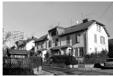
Vue de trois quarts d'un logement ouvrier. Phot. Jérôme Mongreville IVR43_20019000725X
