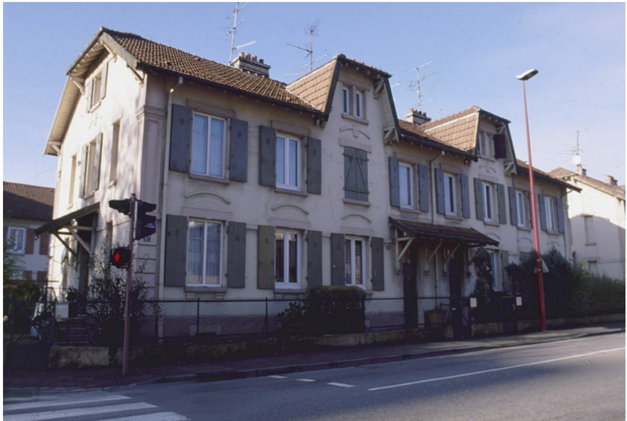
Façade antérieure d'un logement ouvrier rue Voltaire.
