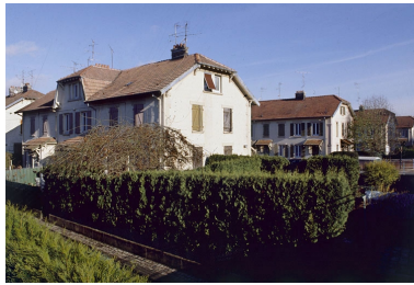
Alignement de logements ouvriers. Phot. Jérôme Mongreville IVR43_20019000731ZA
