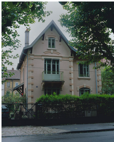
Maison de contremaître rue d'Alsace. Phot. Yves Sancey IVR43_20029000452XA
