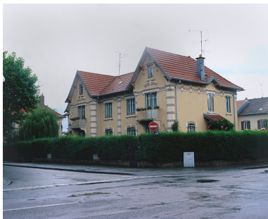
Logement double de contremaître rue d'Alsace. Phot. Yves Sancey IVR43_20029000449XA
