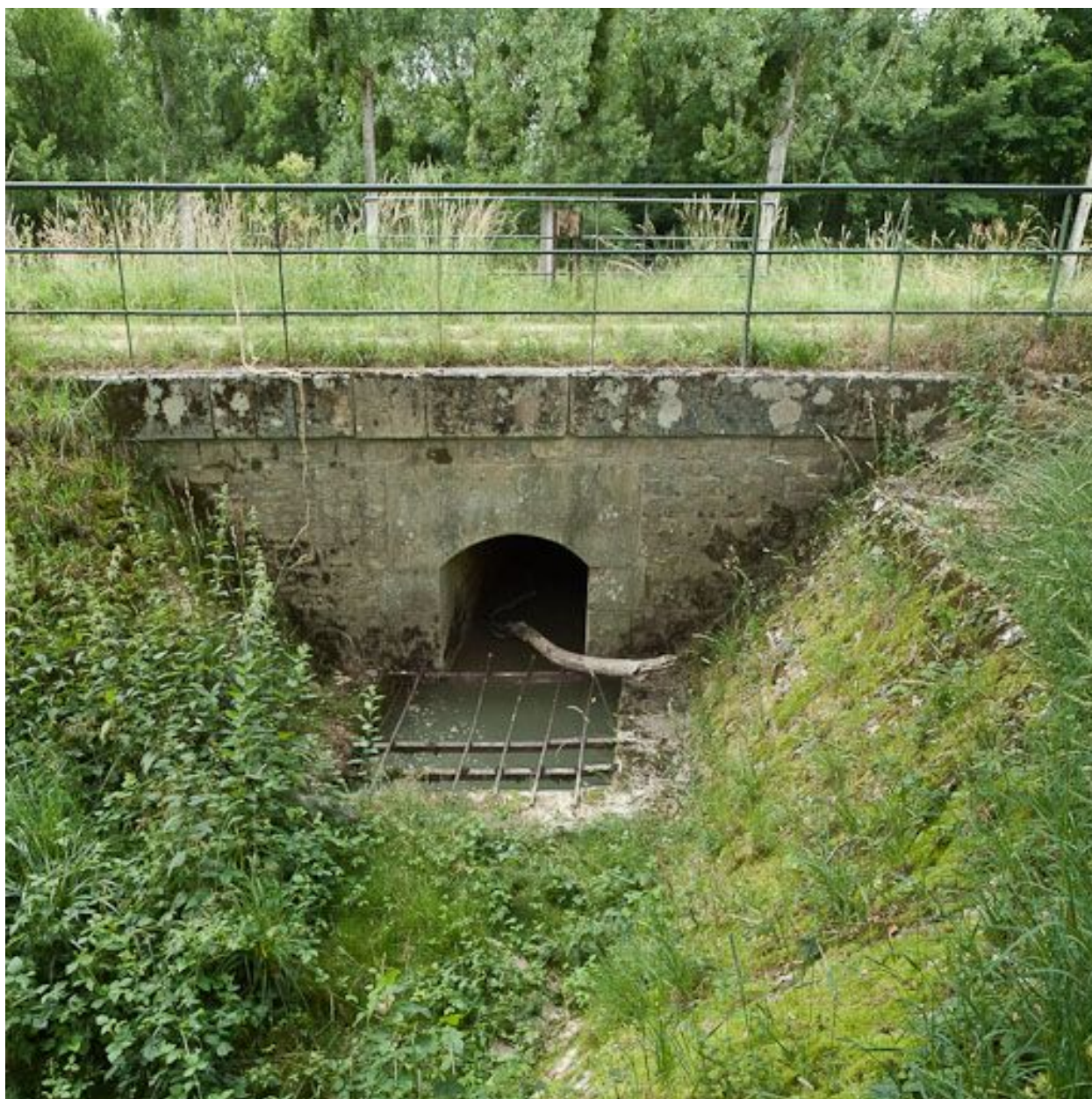
Vue de l'aqueduc.
