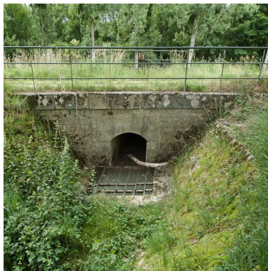
Vue de l'aqueduc.
