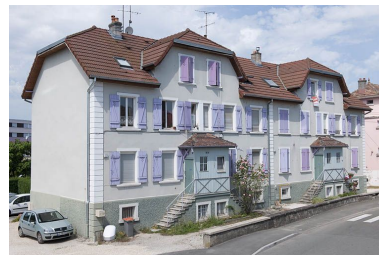
Immeuble sud. Phot. Jérôme Mongreville IVR43_20112502056NUC4A
