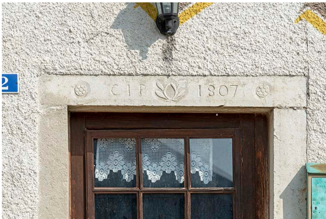
Façade antérieure : linteau daté.
