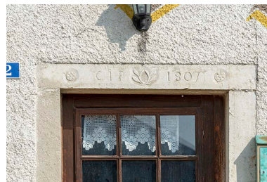
Façade antérieure : linteau daté. Phot. Sonia Dourlot IVR43_20192500692NUC4A
