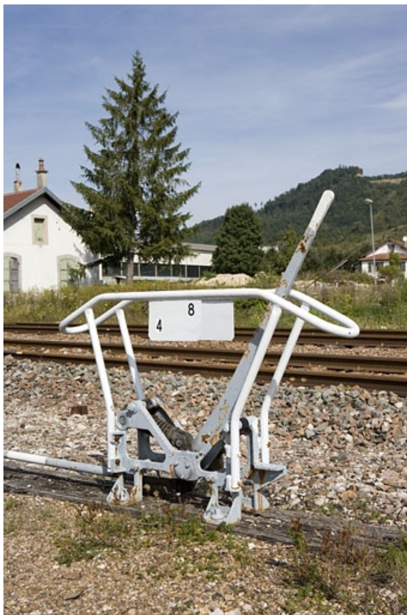
Levier de manoeuvre non enclenché.
