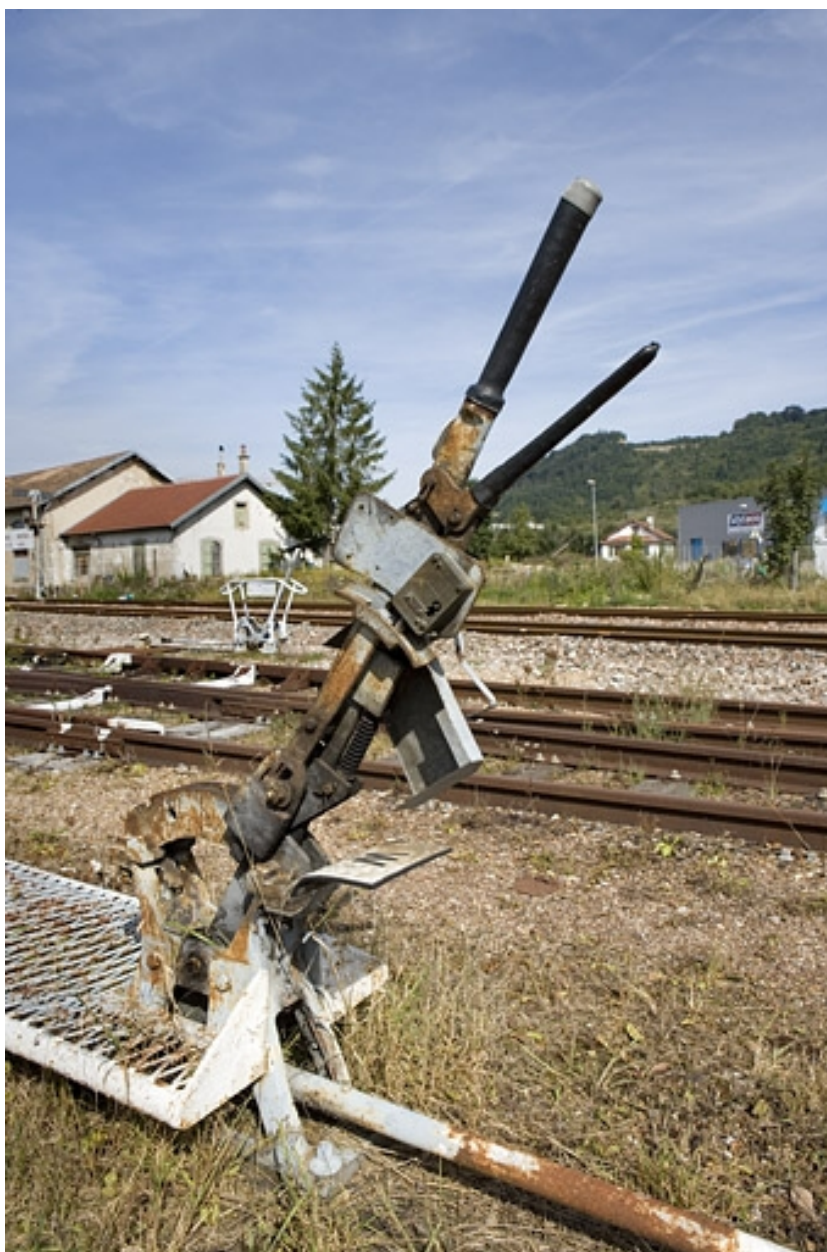
Levier de manoeuvre enclenché.
