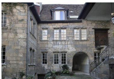
Façade postérieure du logis, de face. Phot. Yves Sancey IVR43_20092501421NUC2A
