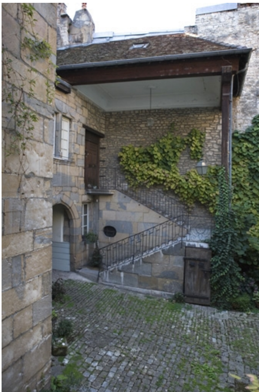
Vue d'ensemble de l'escalier extérieur, de face.
