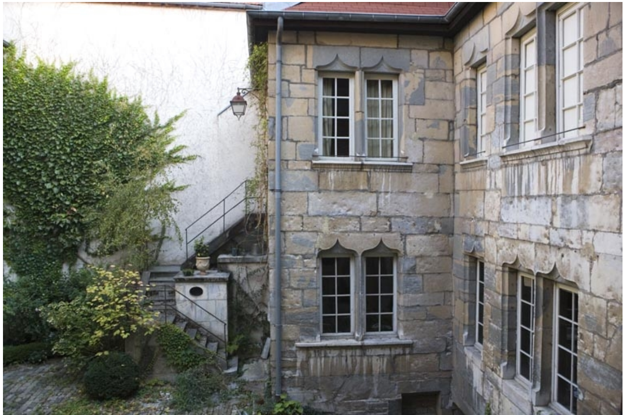
Aile du logis, façade latérale.
