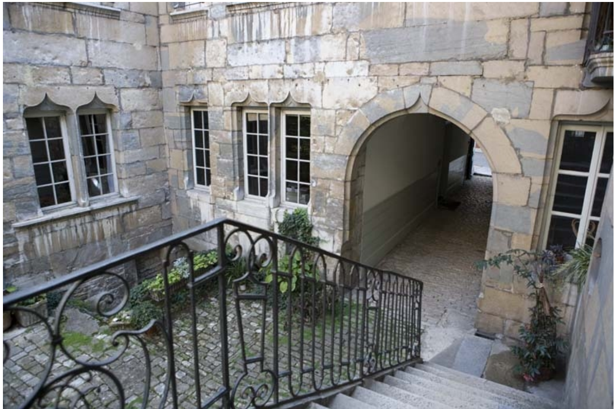
Détail du rez-de-chaussée sur cour depuis l'escalier.
