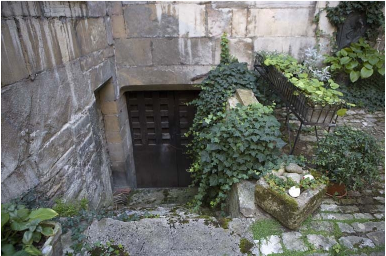
Façade postérieure du logis : entrée de cave.
