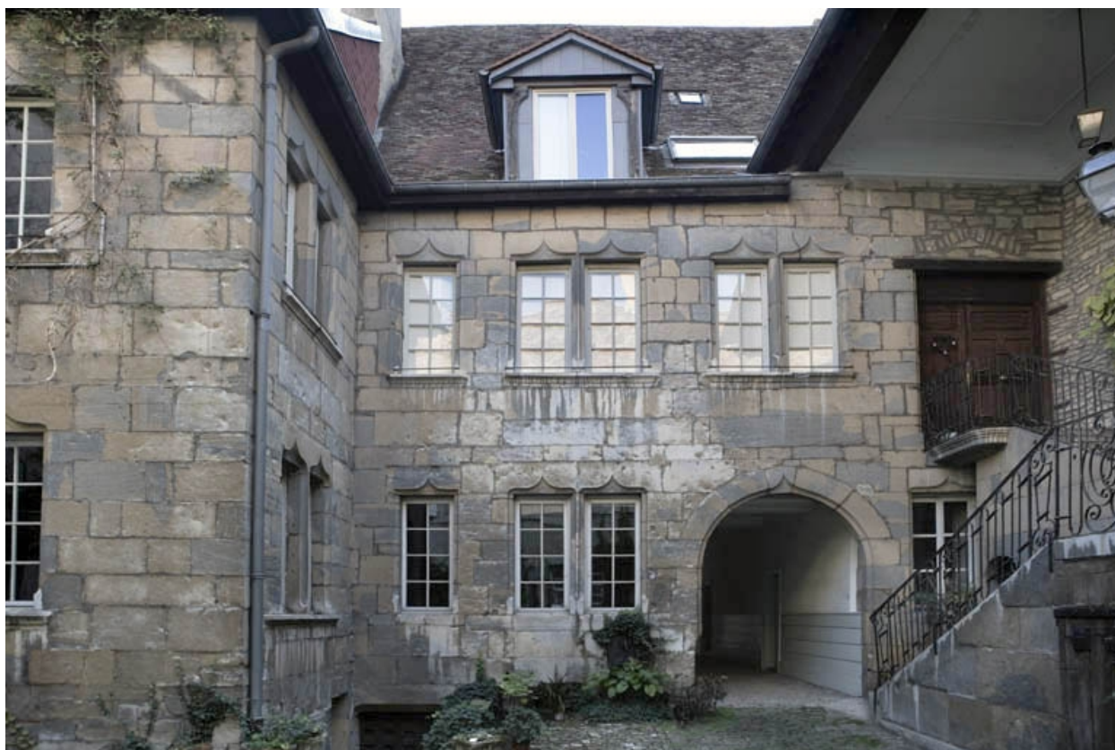
Façade postérieure du logis, de face.
