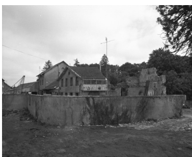
Vestiges de l'atelier de fabrication en 1988. Phot. Yves Sancey IVR43_19887000110X
