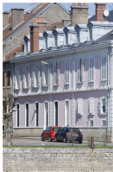
Façade ouest du logement patronal. Phot. Jérôme Mongreville IVR43_20097000215NUC2A
