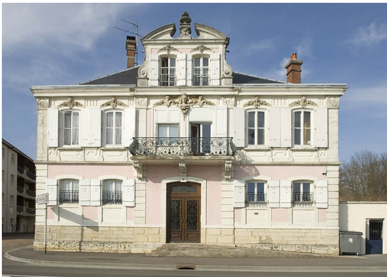
Pignon du logement patronal.
