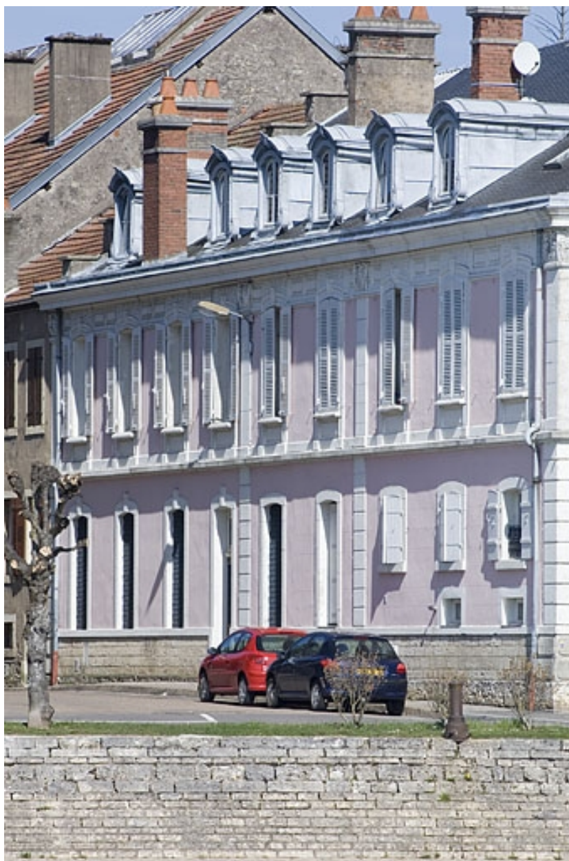
Façade ouest du logement patronal.
