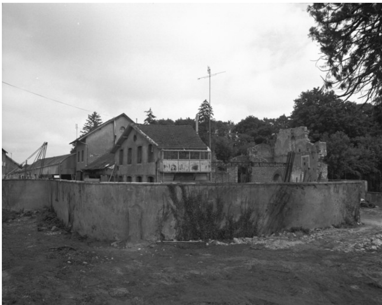
Vestiges de l'atelier de fabrication en 1988.
