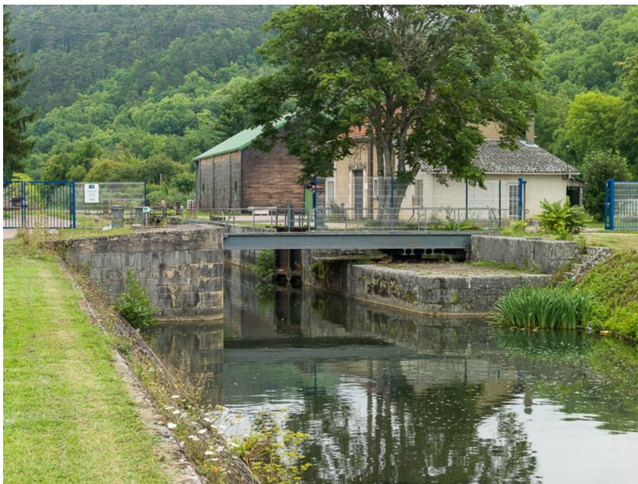
Vue du pont.
