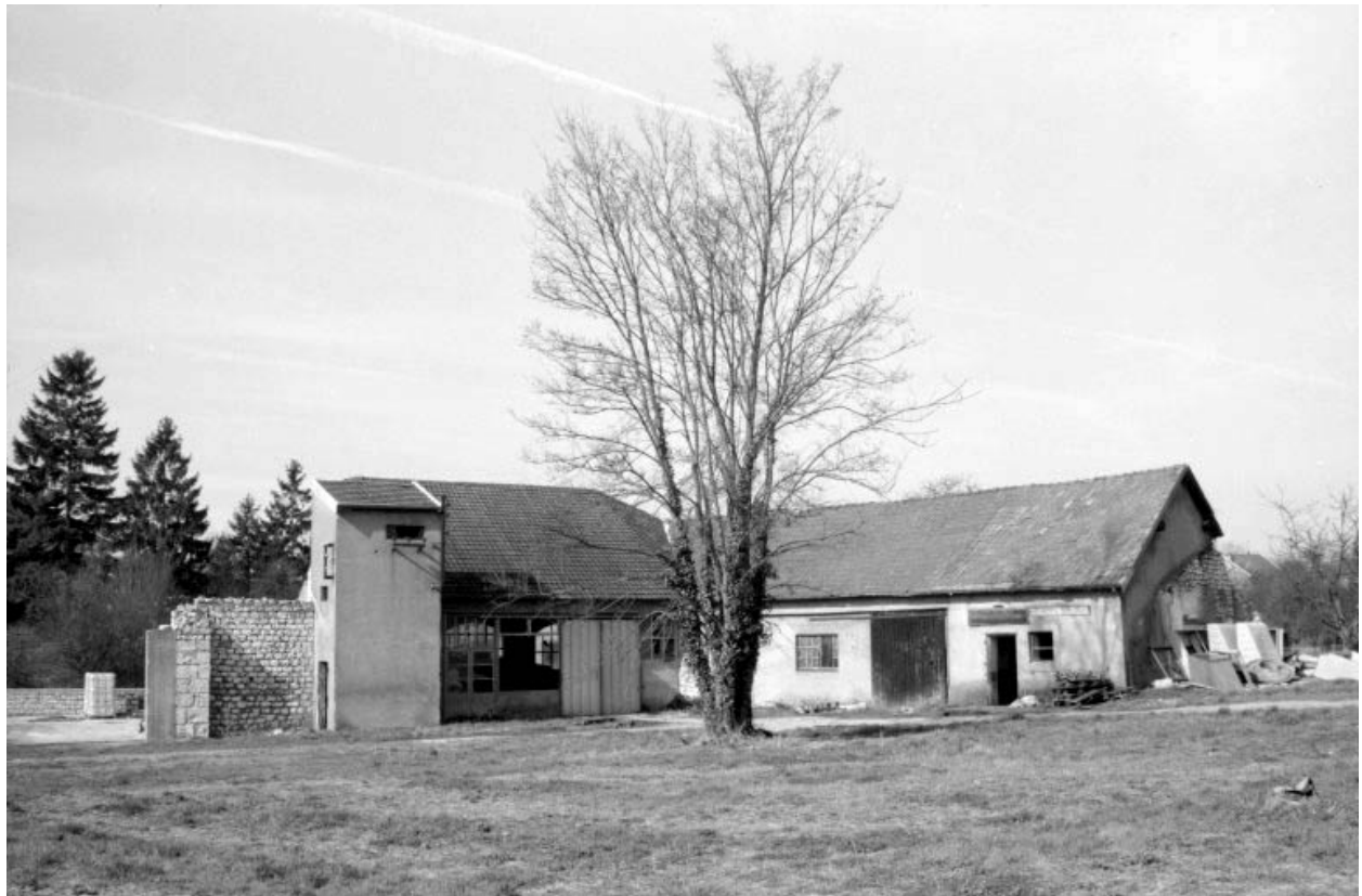
Fabrique d'aliment pour bétail : écuries et transformateur.
