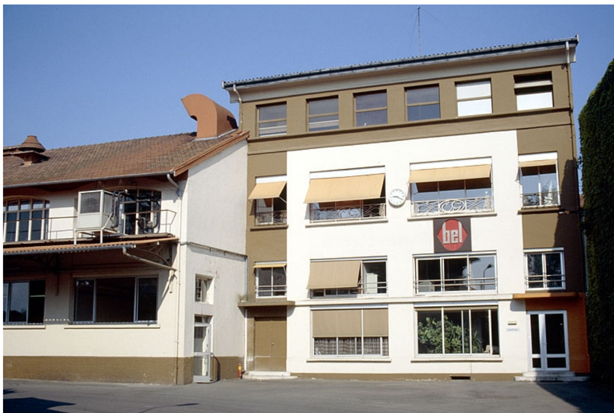
Façade antérieure des bureaux.
