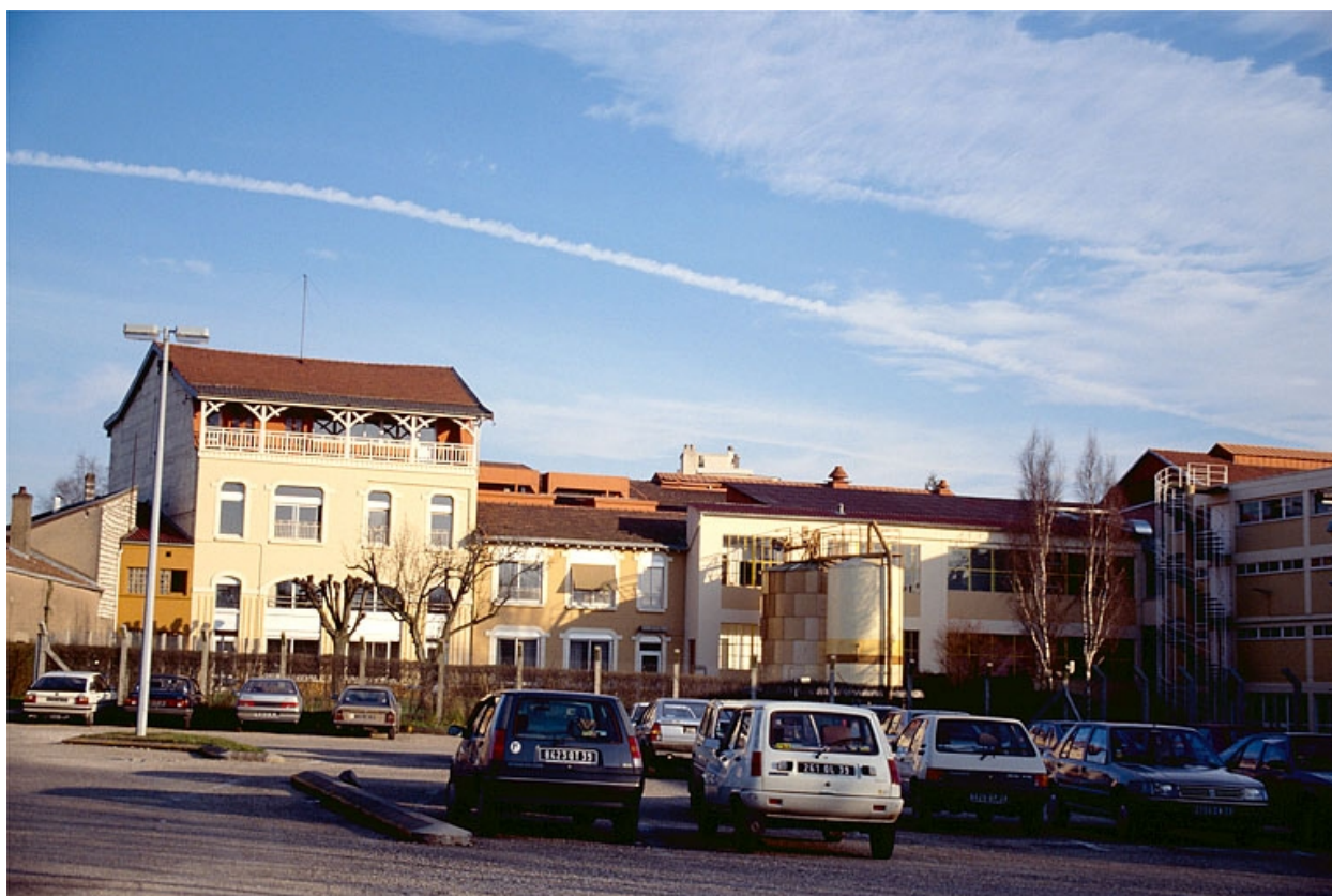
Bureau et atelier de fabrication (E).
