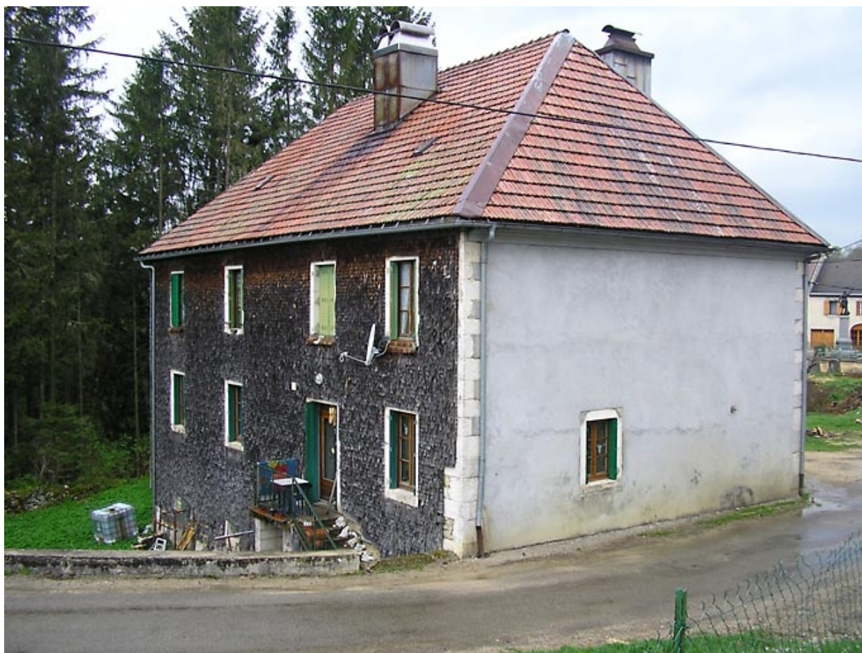
Façade postérieure sud vue de trois quarts.
