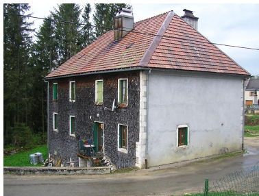
Façade postérieure sud vue de trois quarts. Phot. Marie-Pierre Reynet IVR43_20083900396NUC1A
