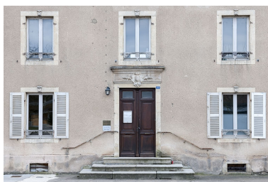
Façade antérieure : baies. Phot. Jérôme Mongreville IVR43_20137000109NUC4A
