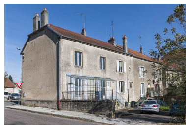
Façade côté jardin. Phot. Jérôme Mongreville IVR43_20127000462NUC4A
