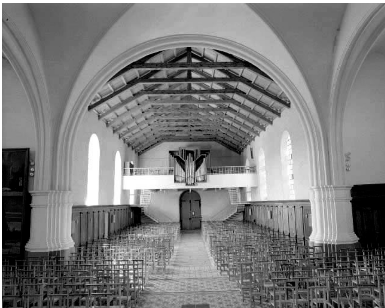
Intérieur : vue depuis le chœur.
