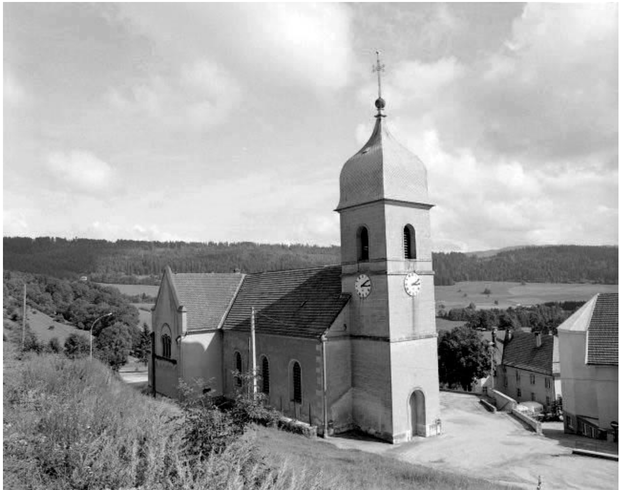
Façade latérale gauche.
