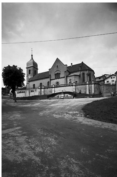
Façade latérale sud. Phot. Yves Sancey IVR43_19752500709V
