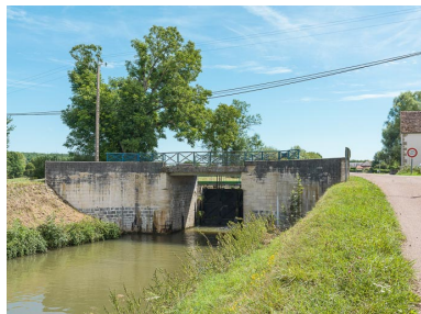
Vue du pont.
