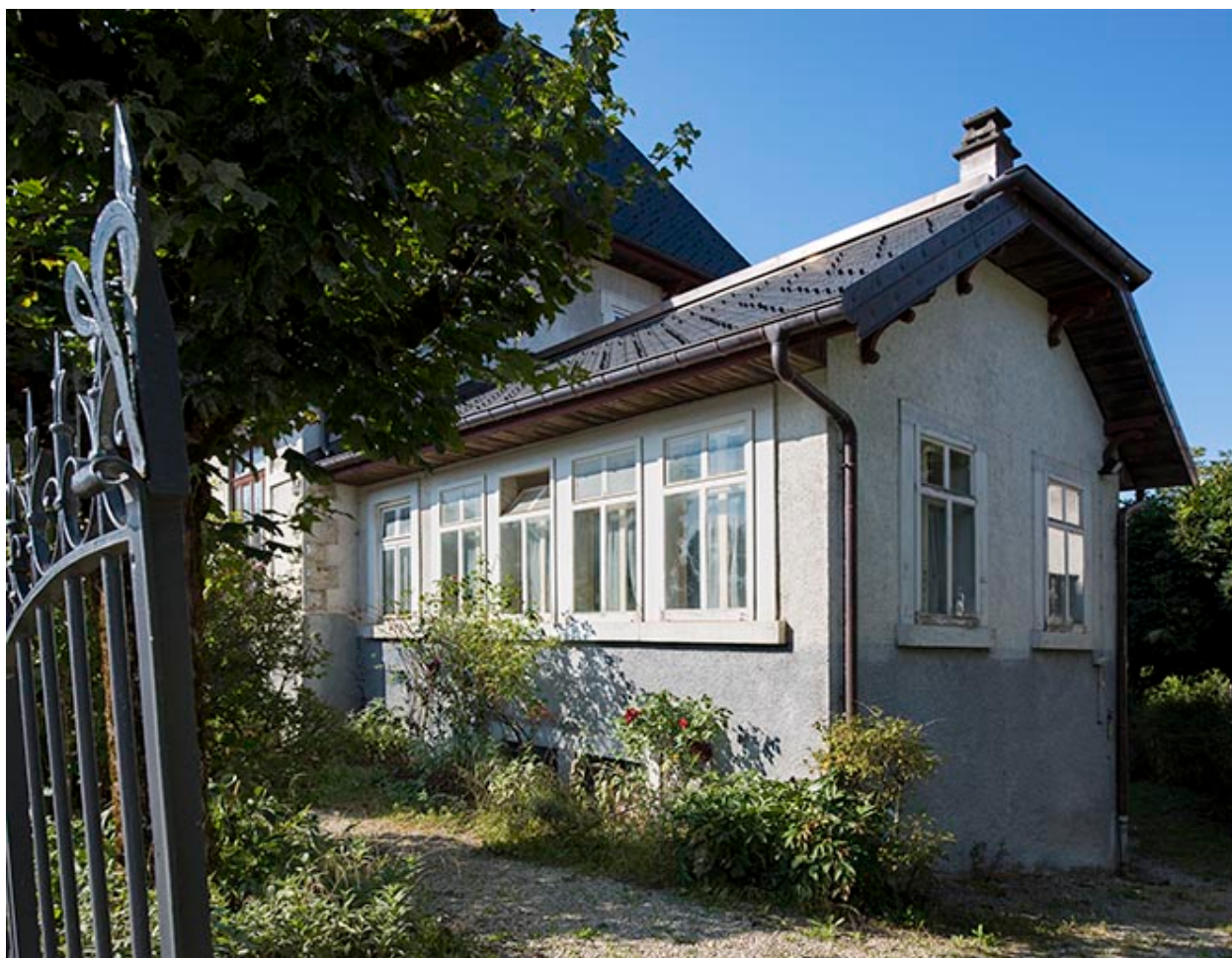
Façades antérieure et latérale droite de l'atelier.
