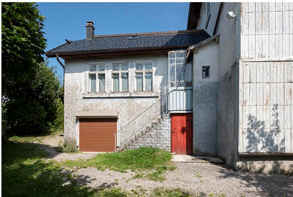
Façade postérieure de l'atelier.
