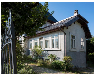
Façades antérieure et latérale droite de l'atelier. Phot. Sonia Dourlot IVR43_20192500346NUC4A
