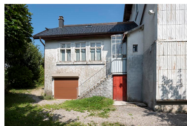
Façade postérieure de l'atelier. Phot. Sonia Dourlot IVR43_20192500344NUC4A
