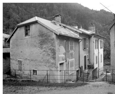
Logement de trois quarts gauche. Phot. Jérôme Mongreville IVR43_19923900444X
