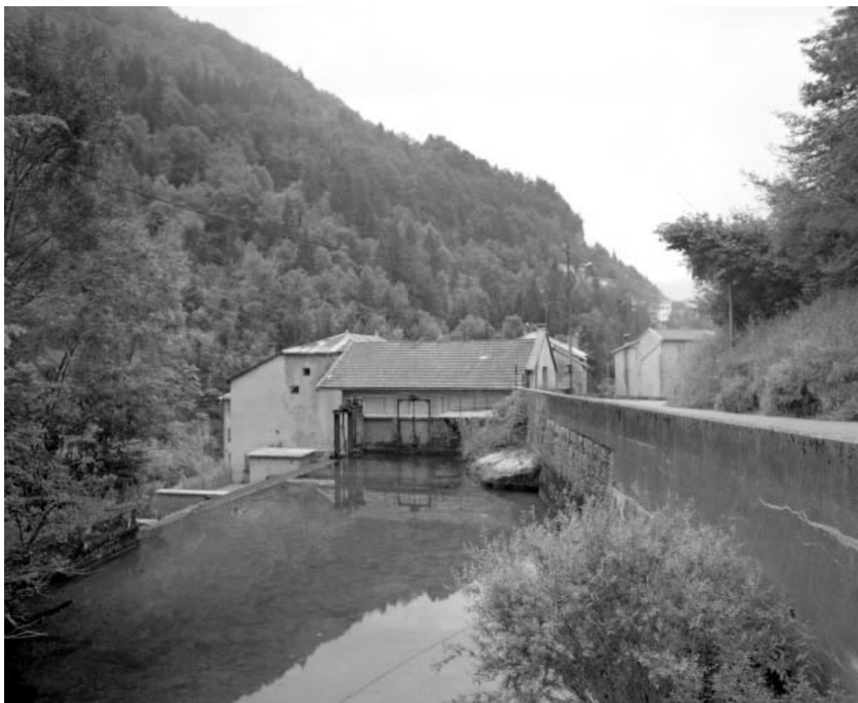
Barrage et prise d'eau vus de l'amont.
