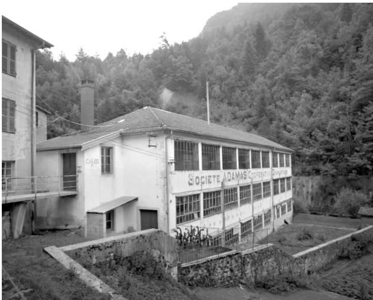
Atelier de fabrication de trois quarts gauche.
