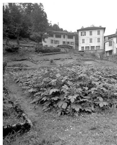
Bureau et logements, depuis les jardins ouvriers. Phot. Jérôme Mongreville IVR43_19923900441X
