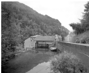
Barrage et prise d'eau vus de l'amont. Phot. Jérôme Mongreville IVR43_19923900451X
