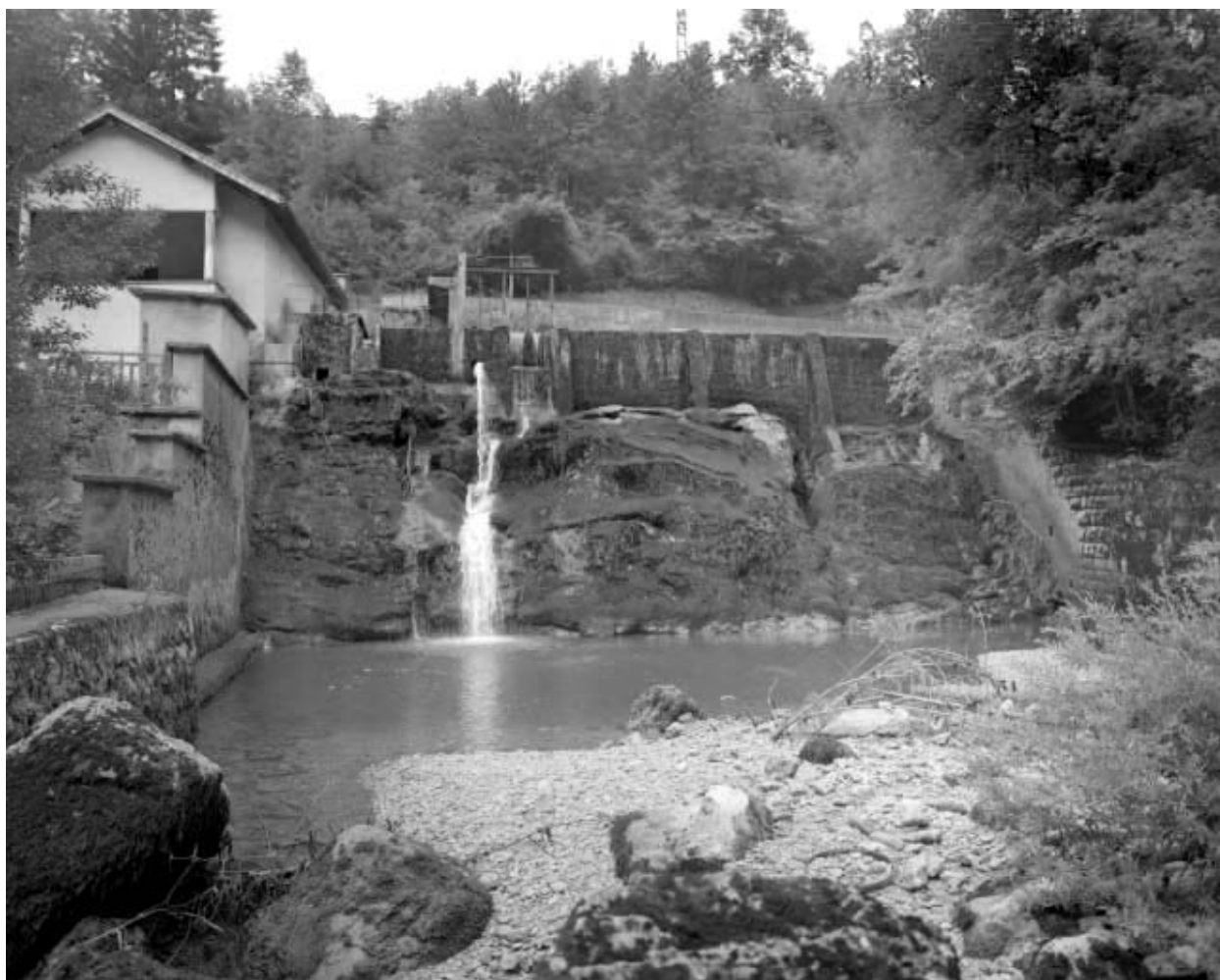
Barrage vu de l'aval.
