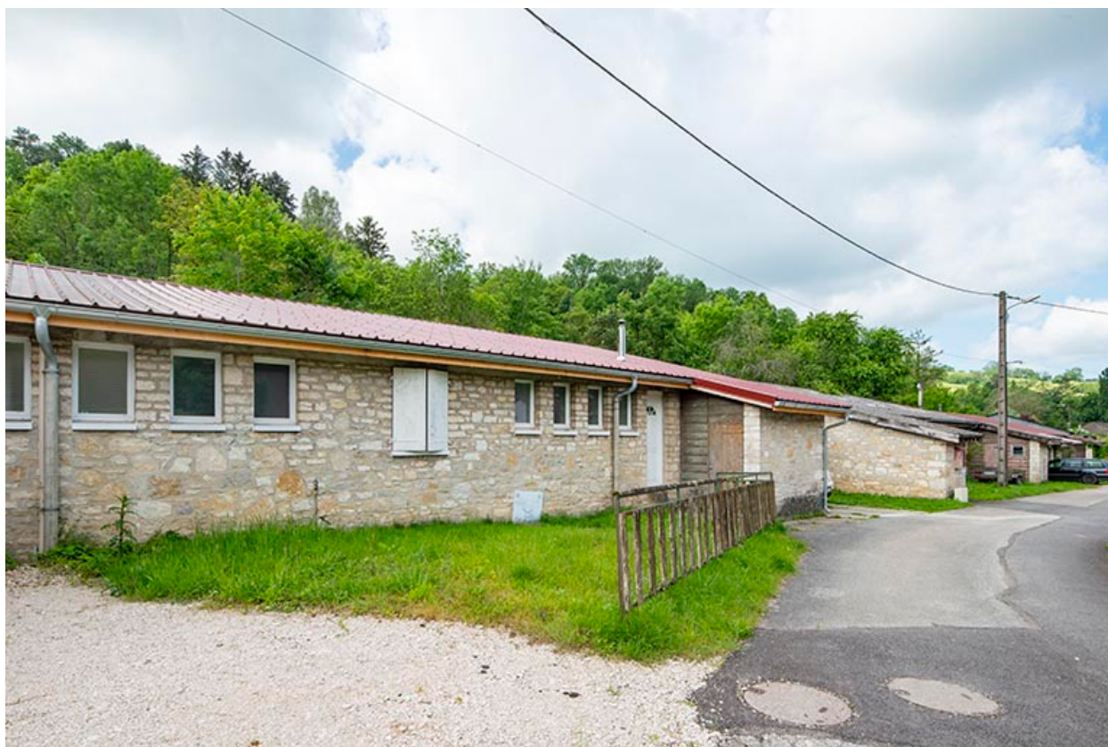
Vue d'ensemble des maisons jumelées.
