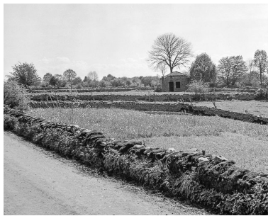
Mur en pierre sèche dit murger.
