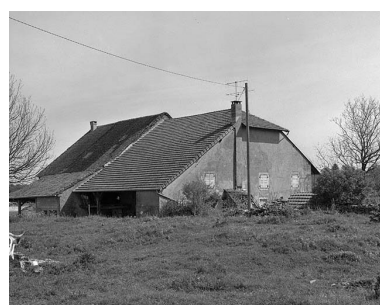
Ferme située rue des Sétrettes. Phot. Yves Sancey IVR43_19813900094X
