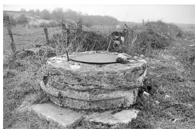
Puits dit puits "romain". Phot. Guy Forestier IVR43_19743901010Z
