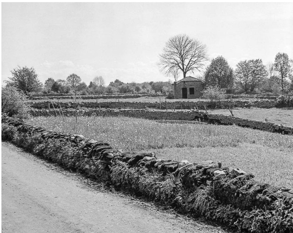
Mur en pierre sèche dit murger.
