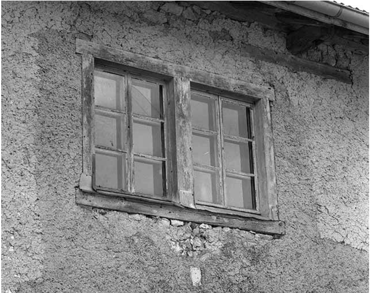
Fenêtre double sur la façade postérieure.
