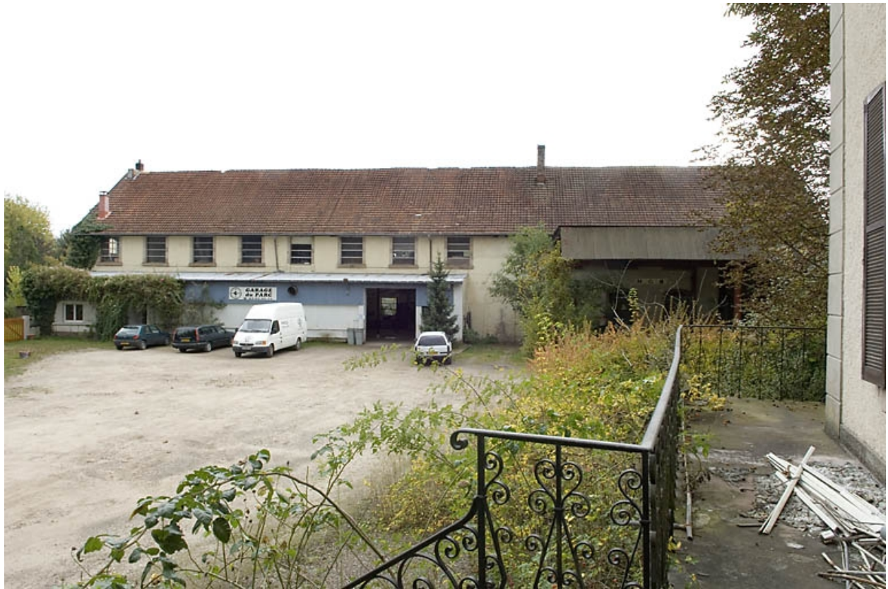
Atelier de fabrication. Vue depuis le nord-ouest.
