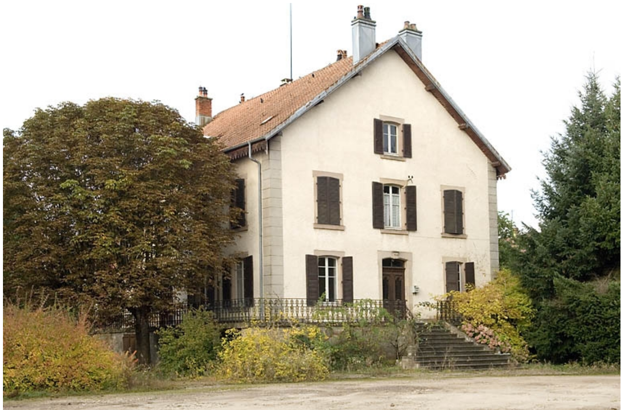
Logement patronal. Vue de trois quarts.
