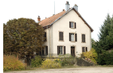
Logement patronal. Vue de trois quarts. Phot. Jérôme Mongreville IVR43_20077000641NUCA
