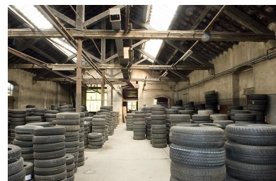
Charpente et couverture de l'atelier de fabrication. Phot. Jérôme Mongreville IVR43_20077000643NUCA
