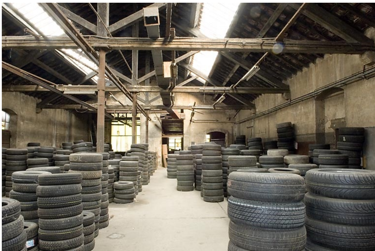
Charpente et couverture de l'atelier de fabrication.
