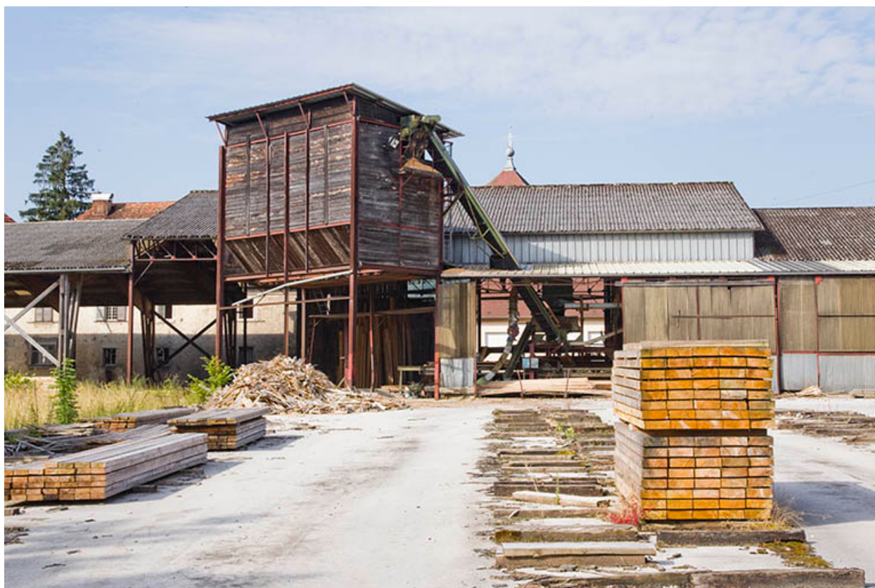
Silo à sciure et hangar de 1969-1970.
