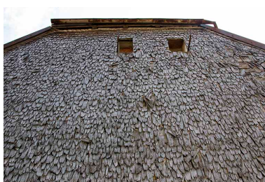
Maison : détail de l'essentage de tavaillons. Phot. Yves Sancey IVR43_20132501272NUC2A
