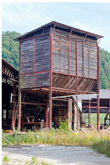
Silo à sciure. Phot. Yves Sancey IVR43_20132501273NUC2A
