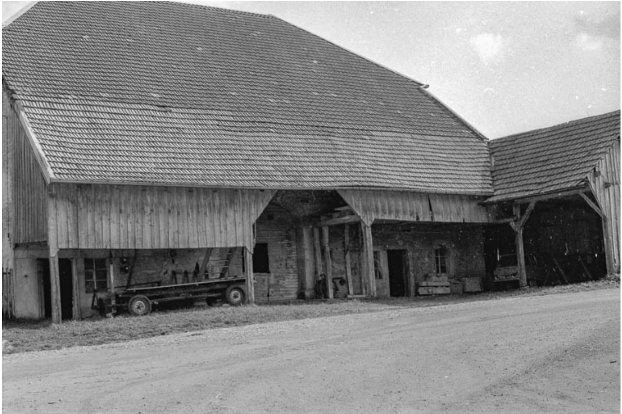
Ferme cadastrée 1945 d 154-155 : façade postérieure.
