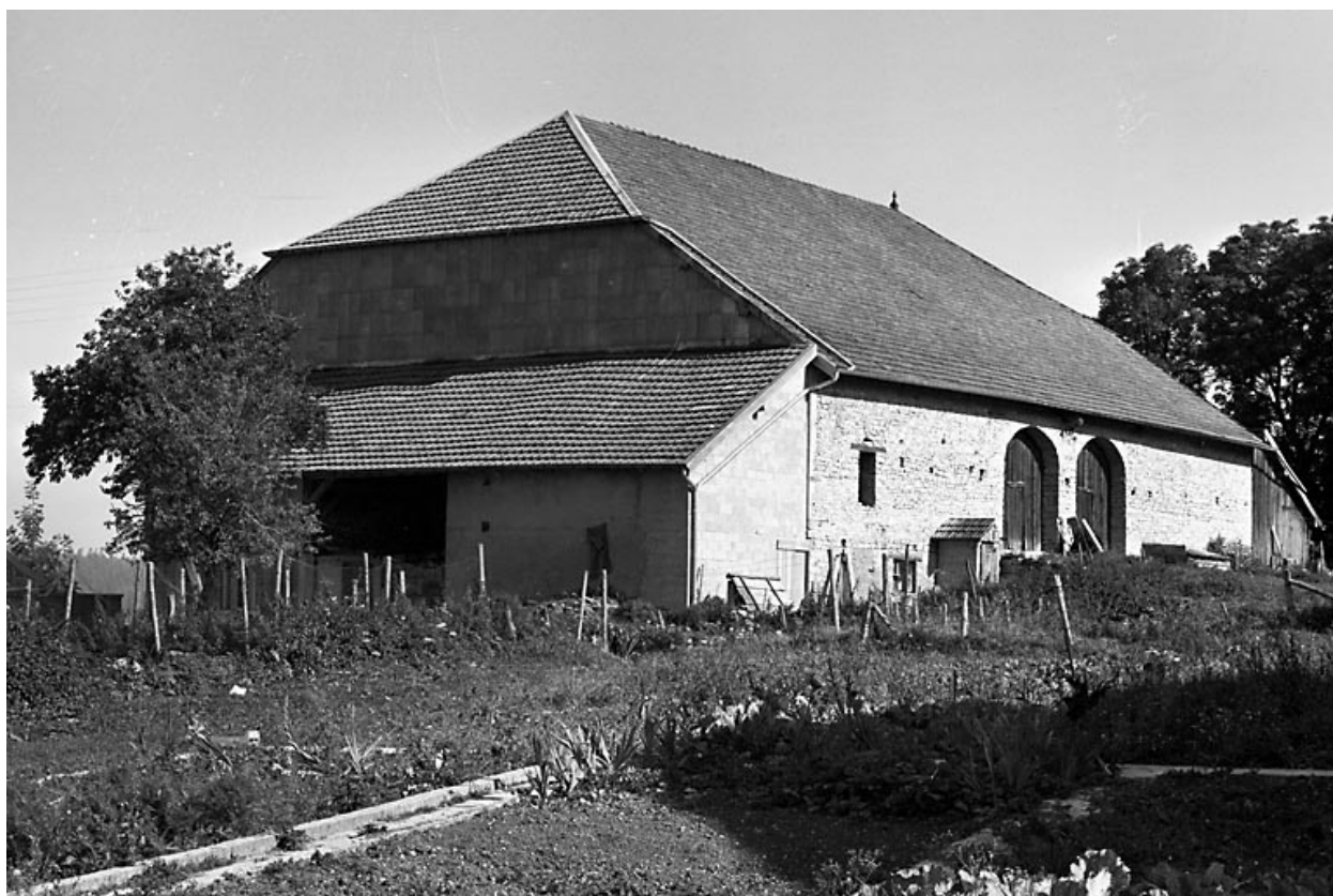
Ferme située rue de l'Eglise : vue d'ensemble.
