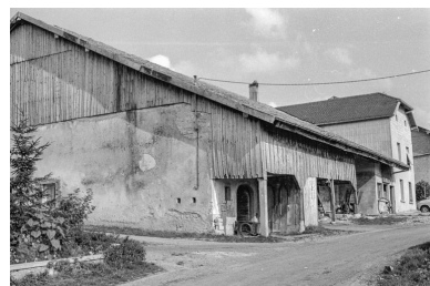
Ferme cadastrée 1945 D 128-129 : façade sur rue. Phot. Gilbert Poinot IVR43_19752501279Z
