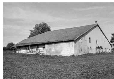
Ferme située route de Levier : vue d'ensemble. Phot. Gilbert Poinot IVR43_19752501329Z
