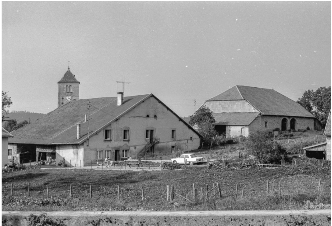
Ferme située rue de l'Eglise : vue d'ensemble.
