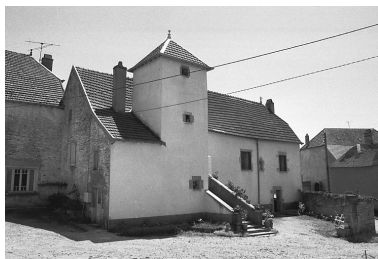
Maison située 3 rue Fénelon. Phot. Bernard Lardière IVR43_19817000126Z
