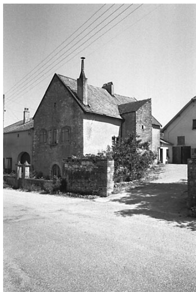
Maison située rue Fénelon. Phot. Bernard Lardière IVR43_19817000140Z
