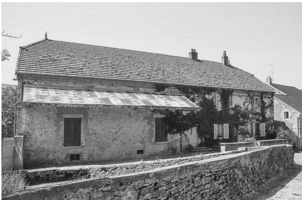
Maison cadastrée 1980 C1 208 : façade antérieure.
