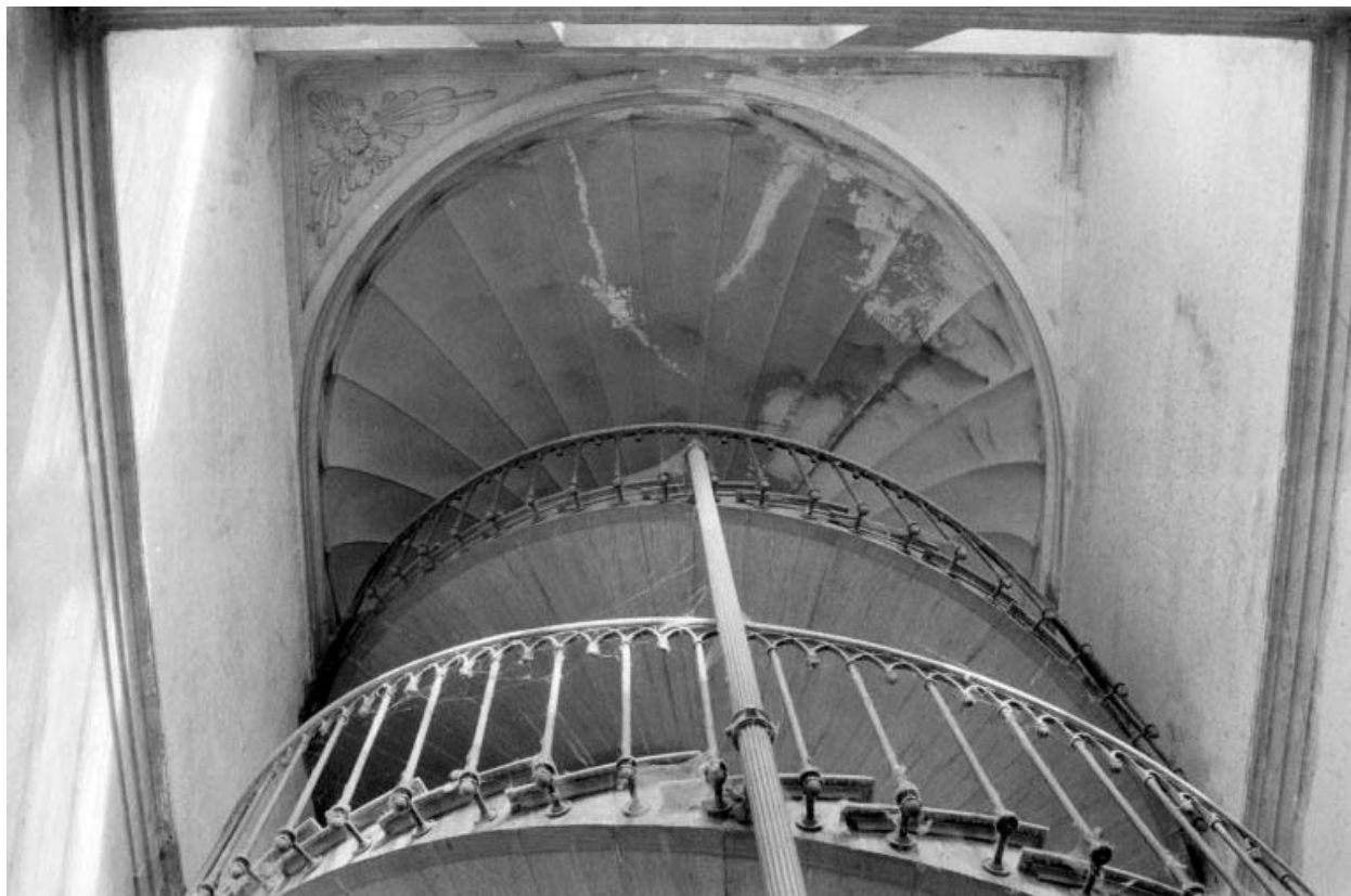
Cage de l'escalier tournant.
