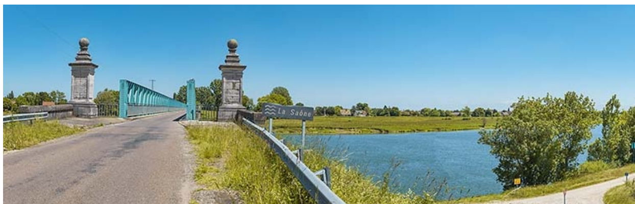
Entrée du pont.
