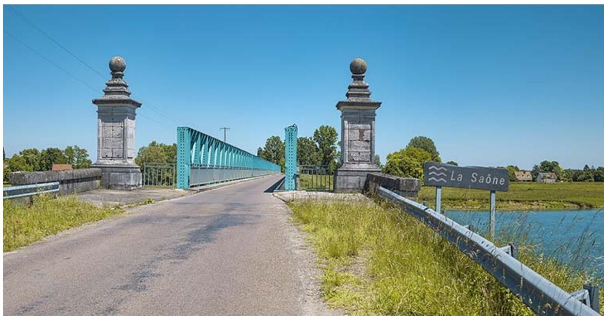
Entrée du pont.
