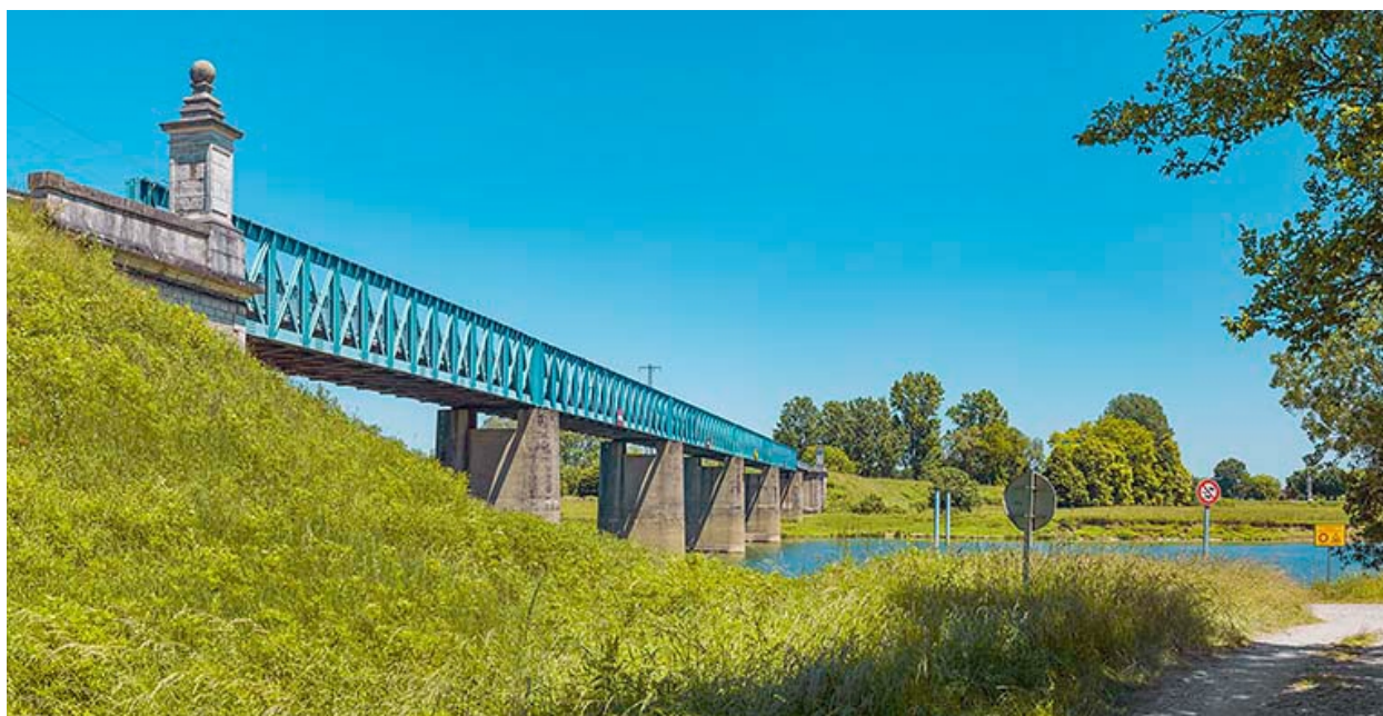
Vue d'ensemble du pont.
