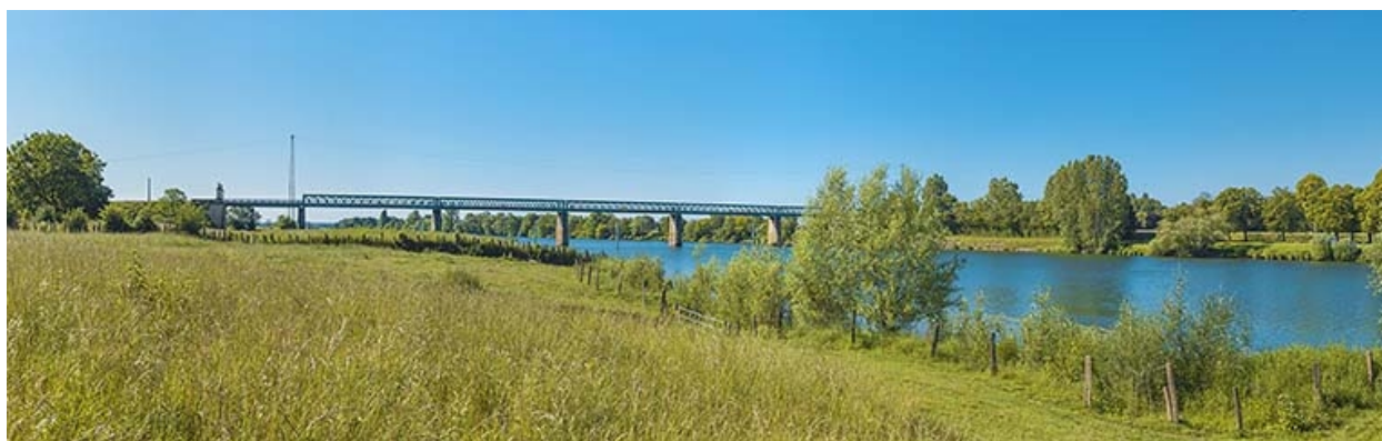
Vue d'ensemble d'amont.
