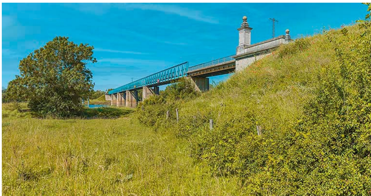
Vue d'ensemble du pont.
