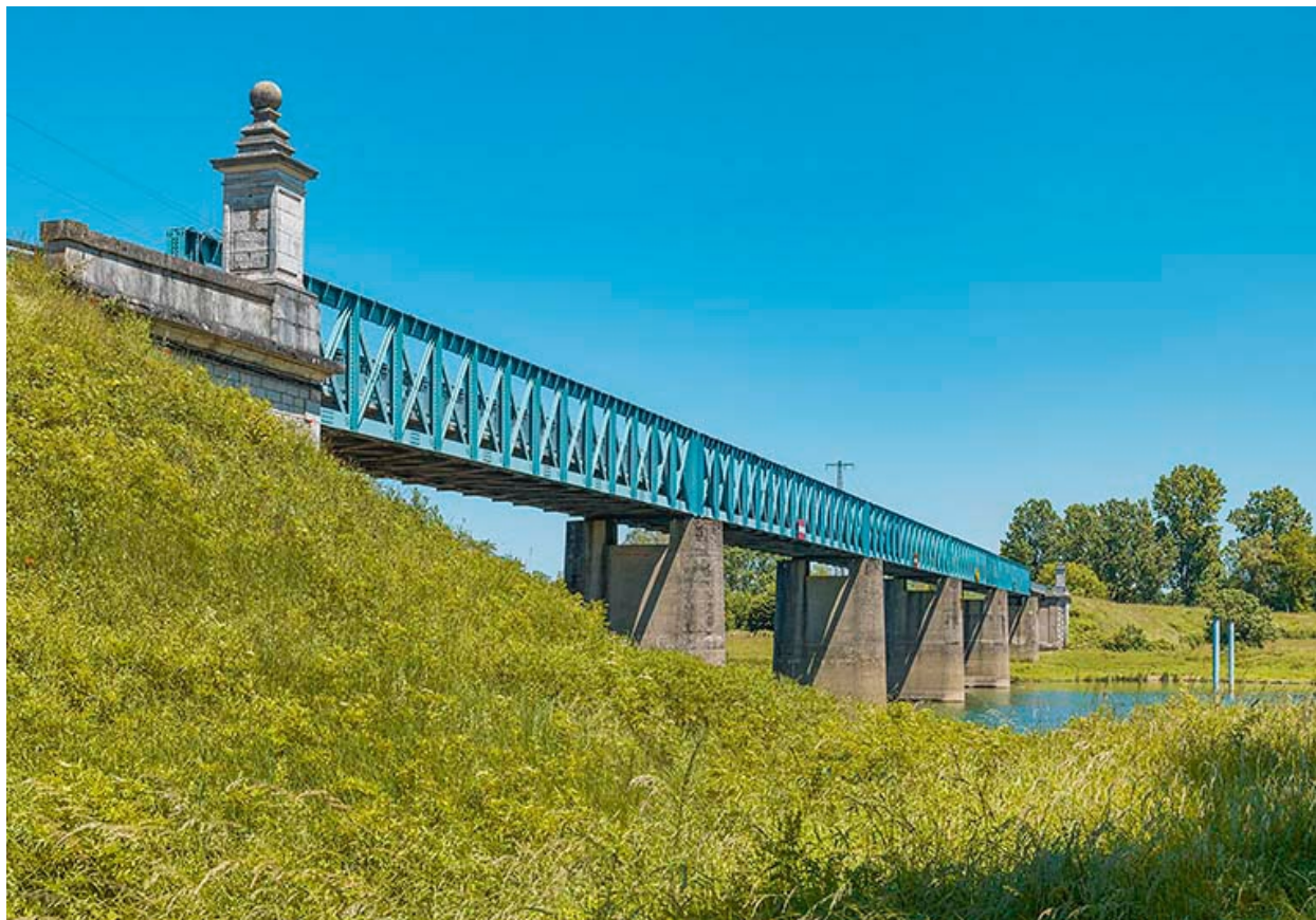
Vue d'ensemble du pont.
