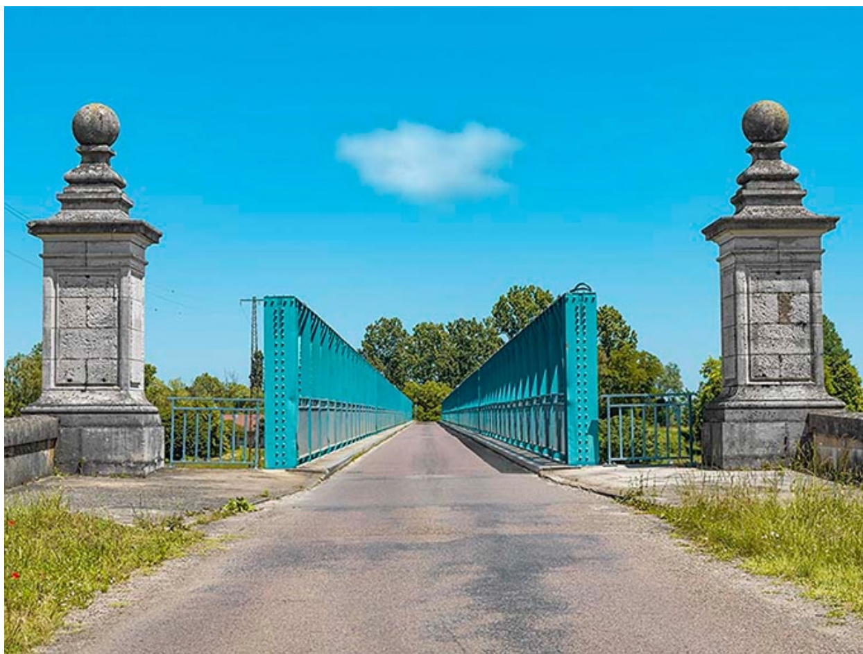
Entrée du pont.
