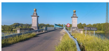
Entrée du pont. Phot. Thierry Kuntz IVR26_20207100323NUC4A
