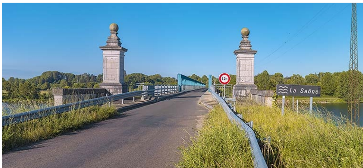
Entrée du pont.
