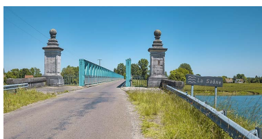
Entrée du pont. Phot. Thierry Kuntz IVR26_20207100320NUC4A
