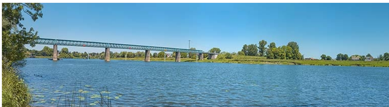
Vue d'ensemble d'amont.
