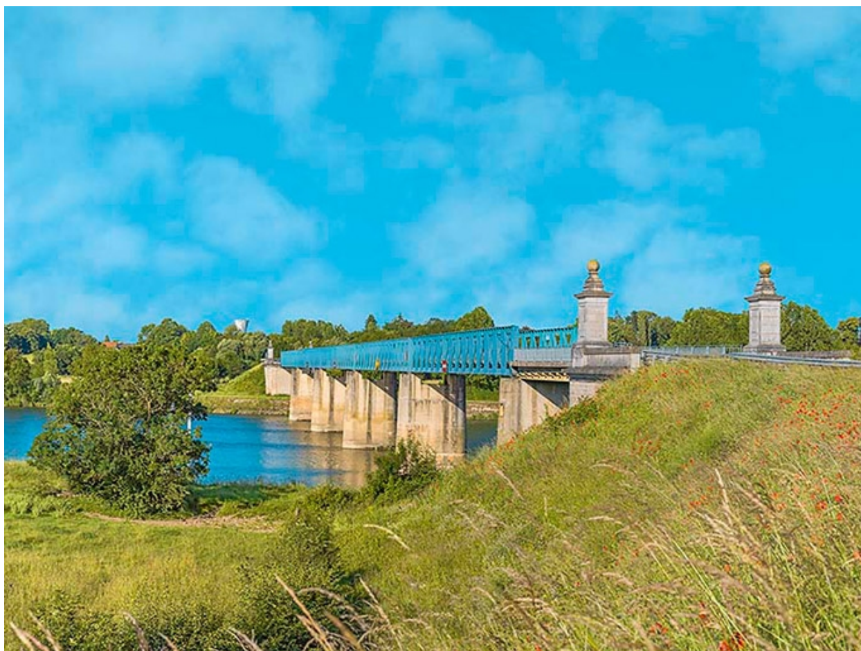
Vue d'ensemble du pont, d'aval.
