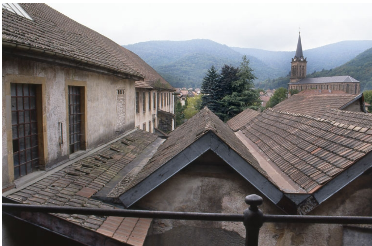
Toitures depuis l'est.
