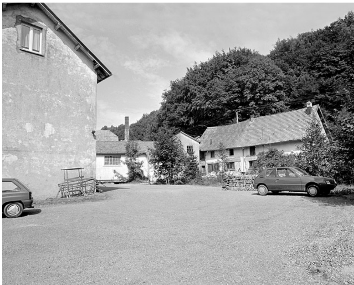
Logements d'ouvriers depuis le sud.
