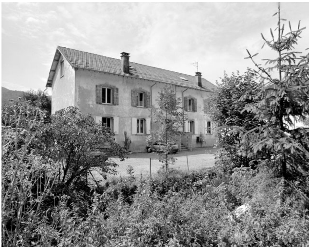
Façade antérieure du logement d'ouvriers.
