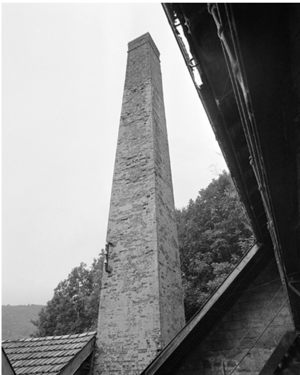
Cheminée de la chaufferie.
