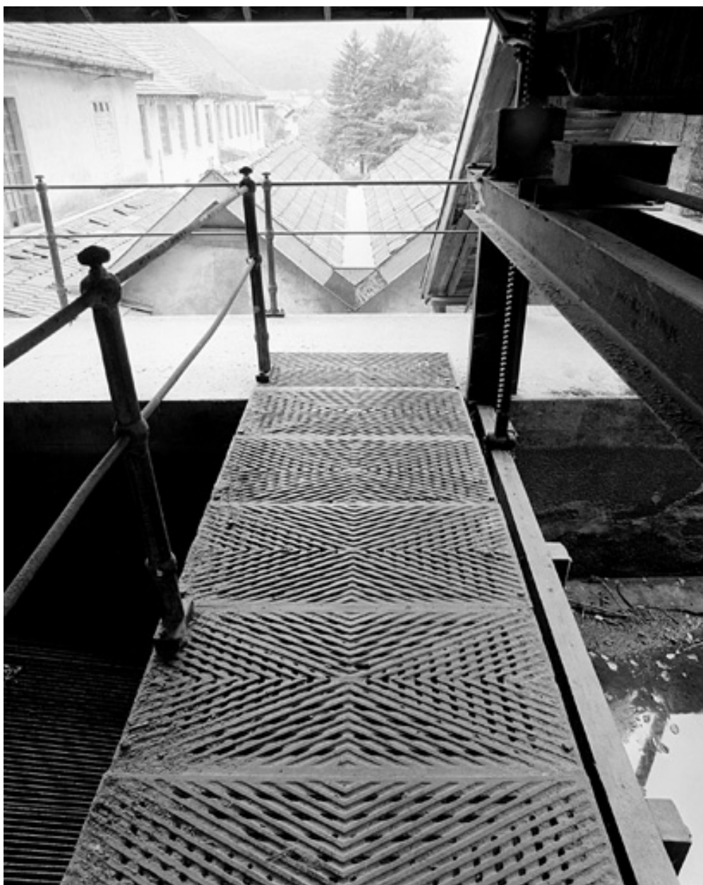
Passerelle sur le canal.
