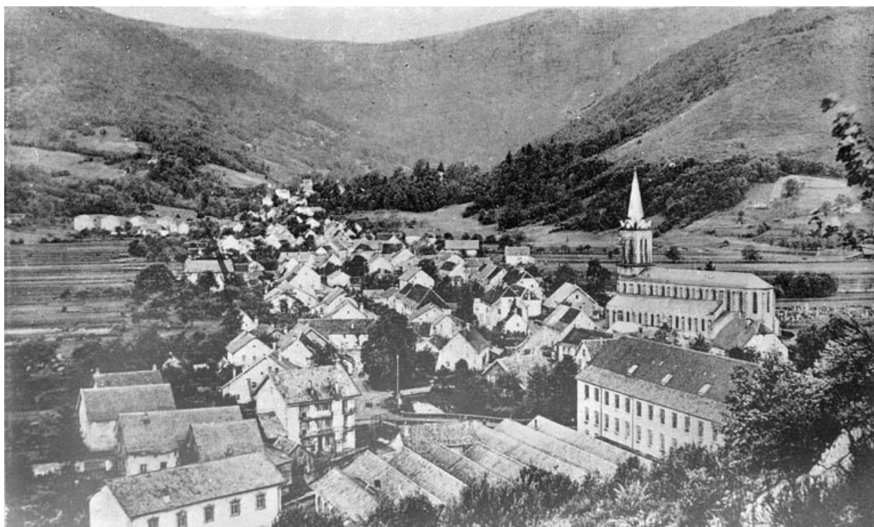
Le Puix. Vue générale.
