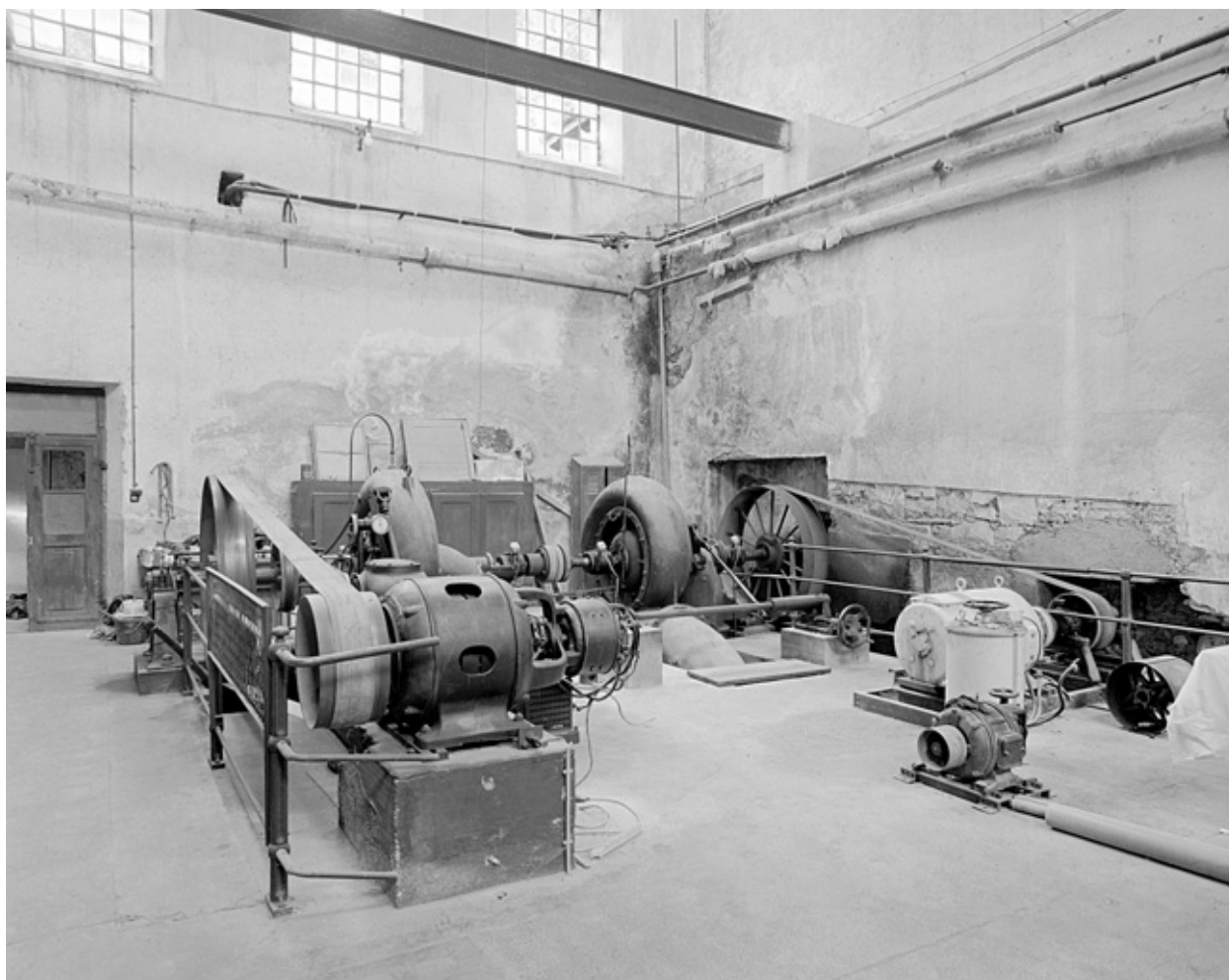
Turbines et alternateurs.
