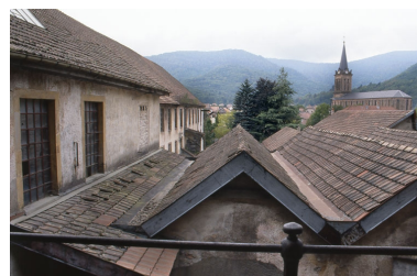
Toitures depuis l'est. Phot. Yves Sancey IVR43_19999000267ZA
