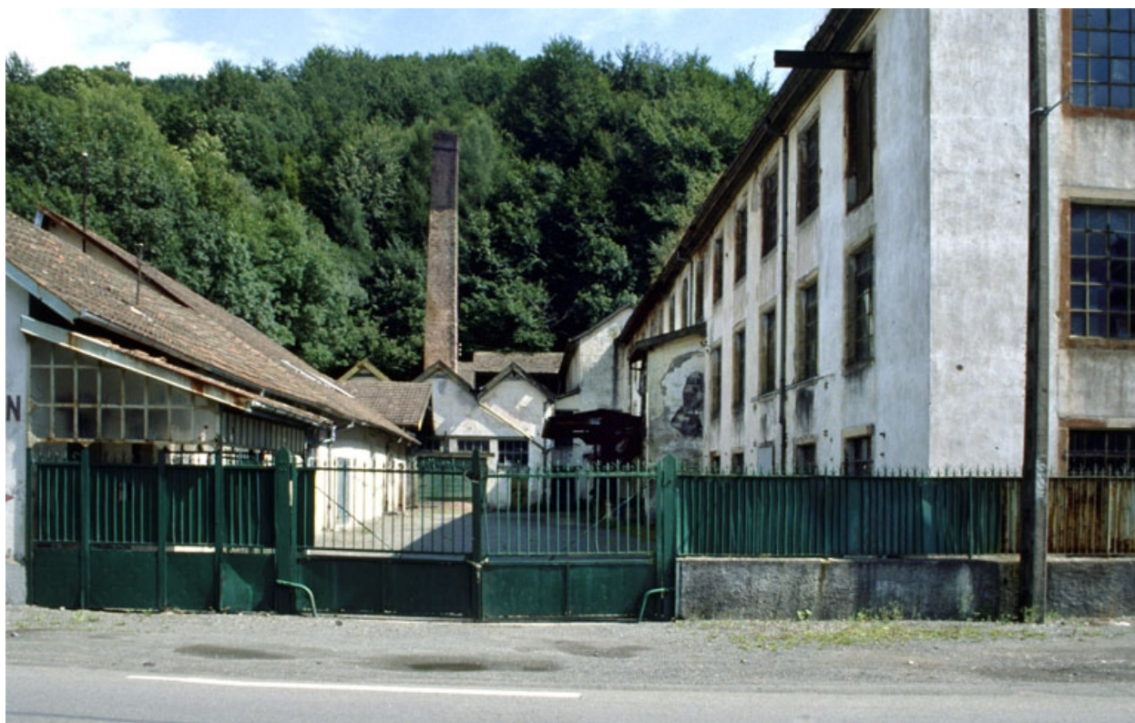
La cour de l'usine.
