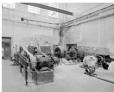
Turbines et alternateurs. Phot. Yves Sancey IVR43_19999000287X
