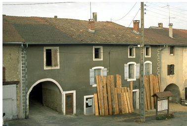
Façade antérieure. Phot. Laurent Poupard IVR43_19923901259ZA
