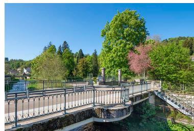
Vue depuis le pont de la rue Béchet. Phot. Jérôme Mongreville IVR43_20223900419NUC4A
