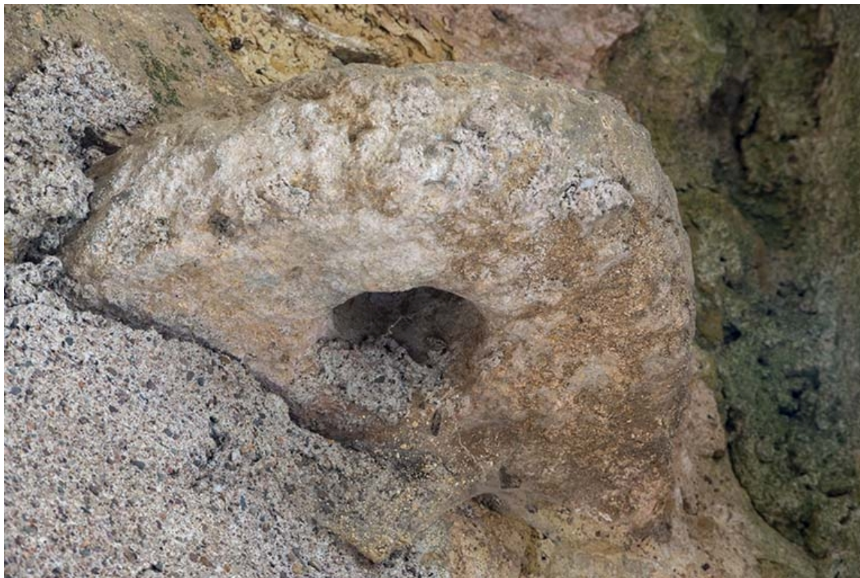
Détail d'un remploi pris dans la maçonnerie.
