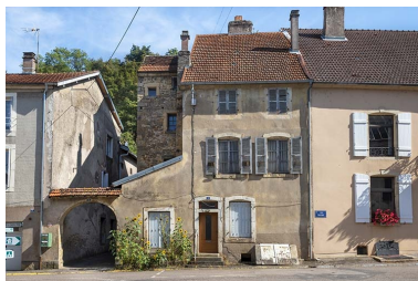
Façade sur rue. Phot. Jérôme Mongreville IVR43_20217000575NUC4A
