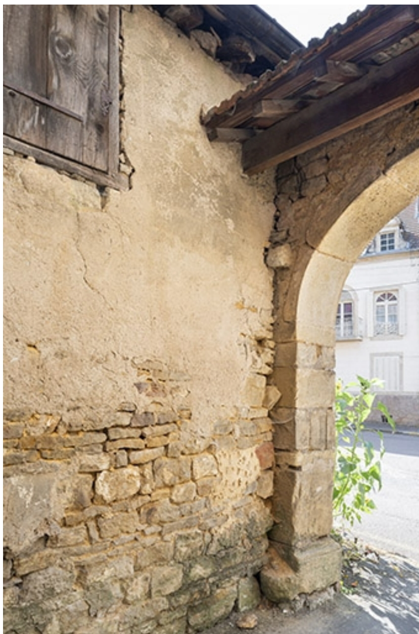
Détail de maçonnerie depuis la cour.
