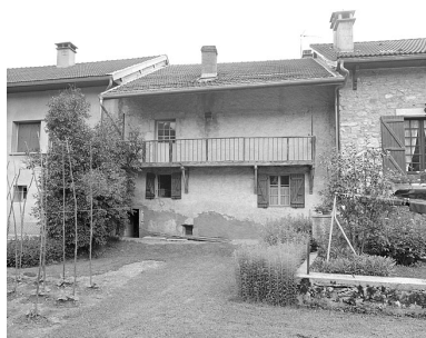
Ferme située 240 rue de Chiriat. Phot. Jérôme Mongreville IVR43_19973900833X
