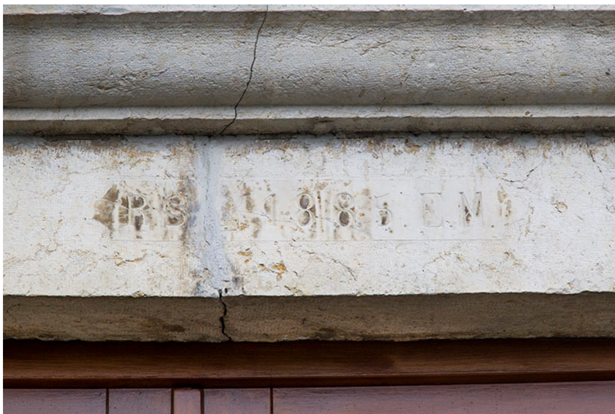
Linteau de l'entrée daté.
