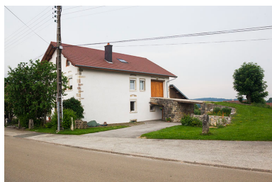
Façade latérale droite et pont de grange. Phot. Yves Sancey IVR43_20132501317NUC2A
