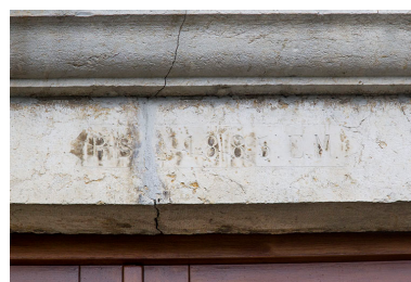
Linteau de l'entrée daté. Phot. Yves Sancey IVR43_20132501319NUC2A
