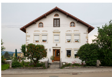
Façade antérieure. Phot. Yves Sancey IVR43_20132501318NUC2A
