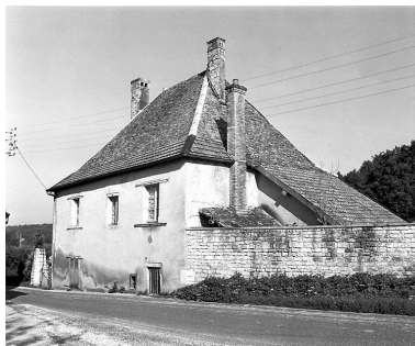
Façade postérieure. Phot. Yves Sancey IVR43_19802501187X
