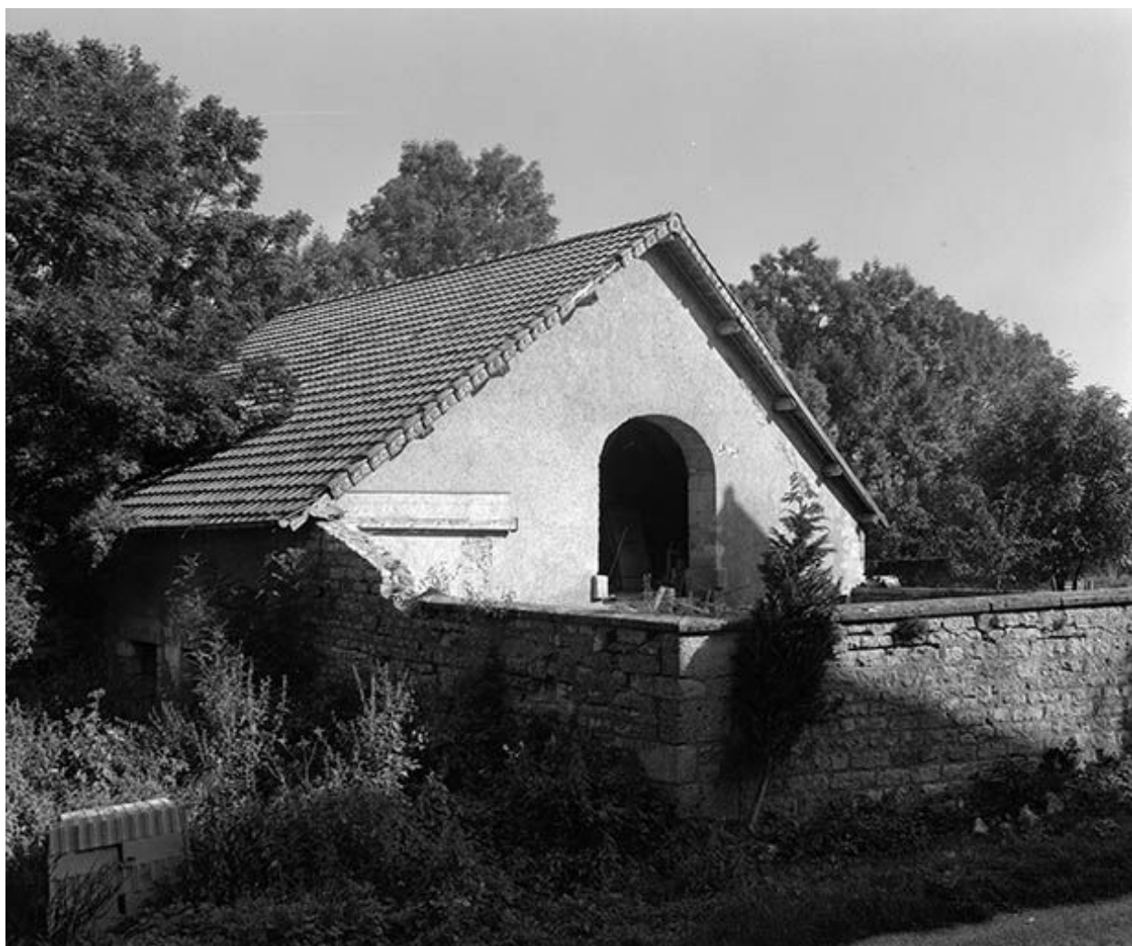
Façade antérieure des parties agricoles.
