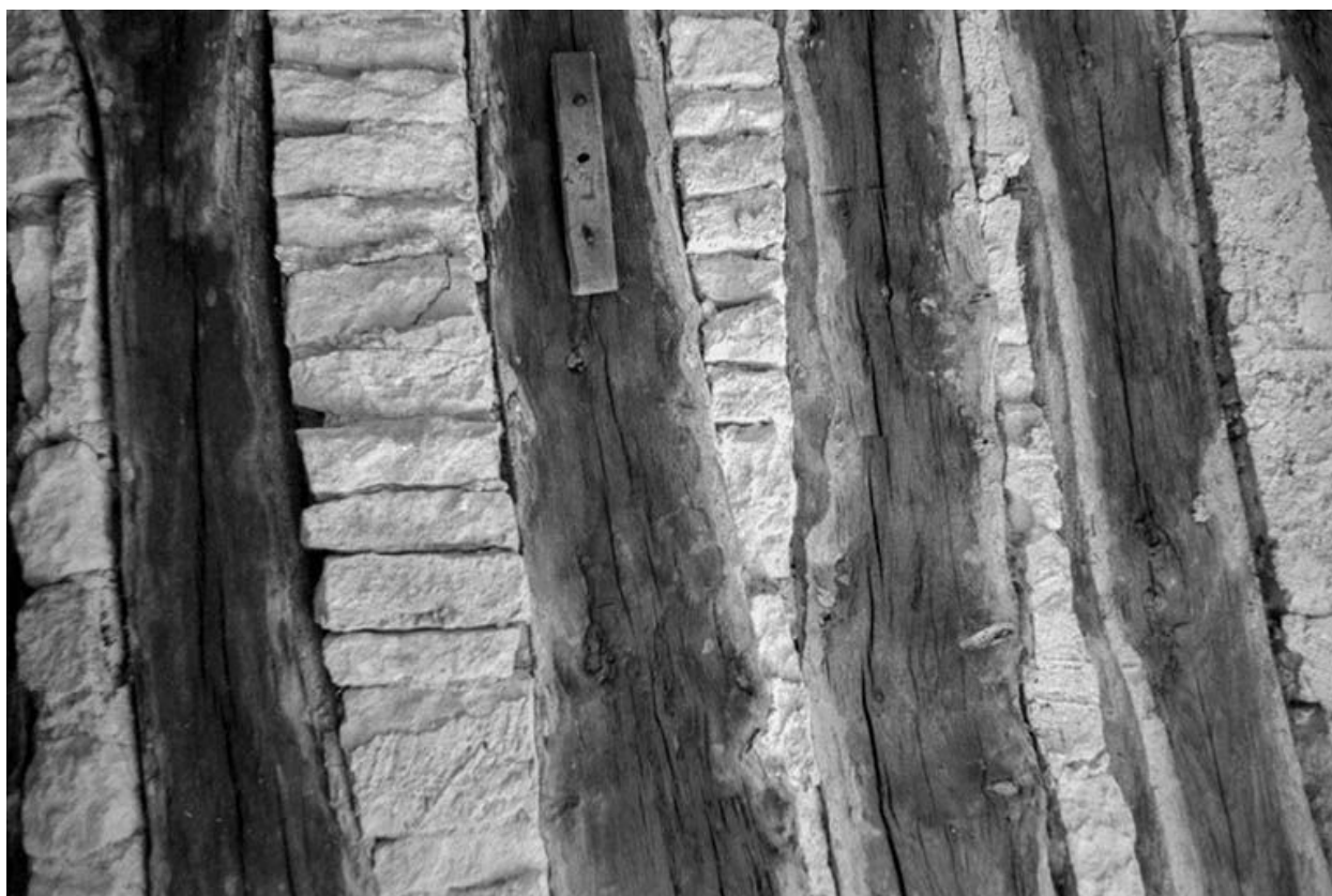
Intérieur des parties agricoles : le plafond.
