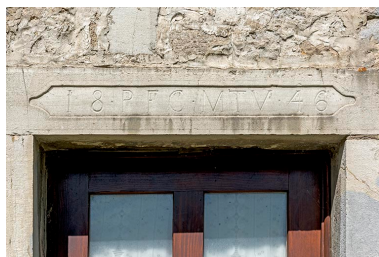
Façade occidentale : linteau daté 1846. Phot. Sonia Dourlot IVR43_20172500444NUC4A
